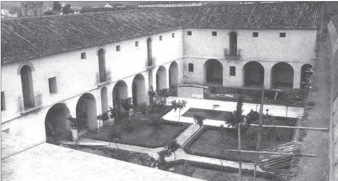
Fig. 7 y 8: El patio morisco antes y después de su restauración (Solano, 2007).
