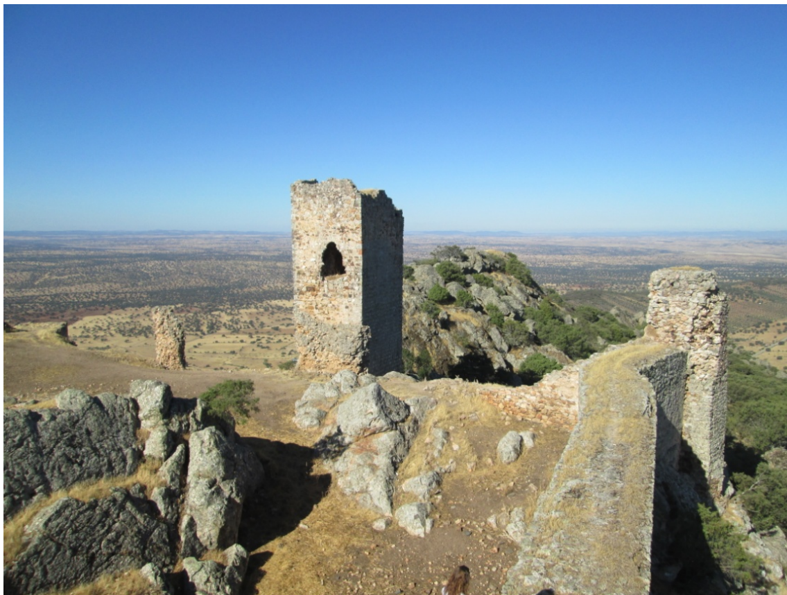
Fig. 14. Restos conservados en el Castillo de Miramontes. Posible torre del homenaje.
