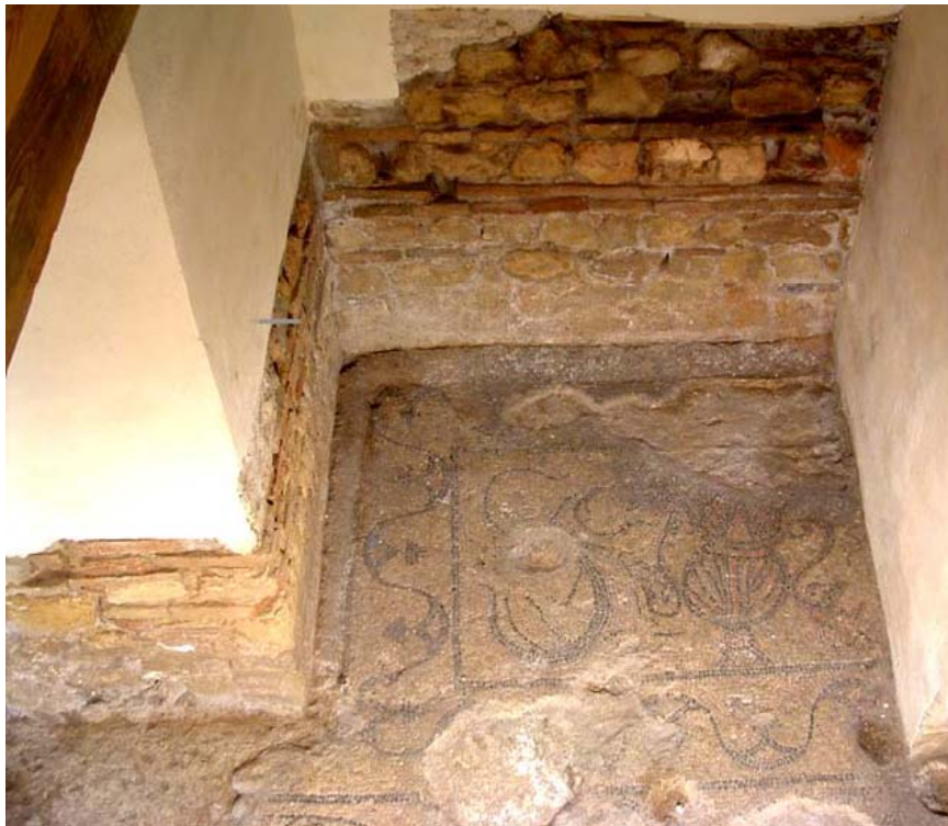
Lám. 8: Pavimentos musivos y paramento de opus vitatum , bajo la sala de oración de la Mezquita-Catedral (Sánchez, 2006: 279).
