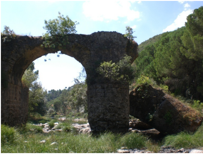
Lám. 27: Puente califal sobre el Guadiato (Foto: autora).
