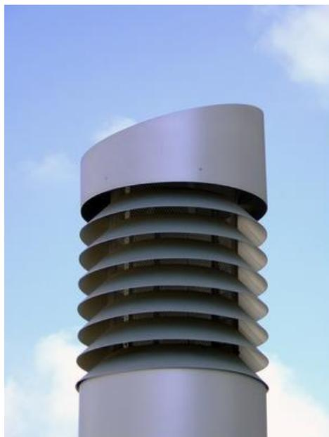
**Imagen 19.** Tubos para evacuación de gases.
