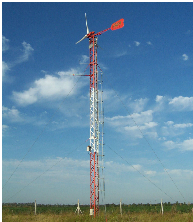
Figura C.7 Estación electro-eólica experimental del Grupo de Electrónica Aplicada.
