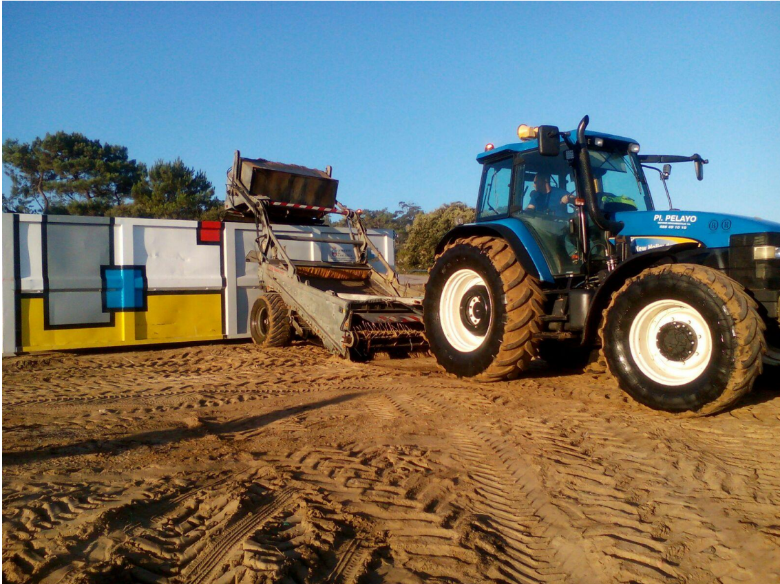
Fig. 19 Tractor con cribadora depositando el residuo en contenedor.
