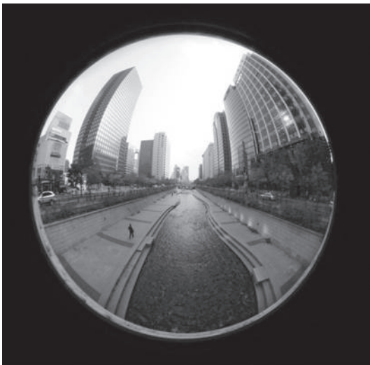
図4 毛塵橋の水平下流方向写真 (2008年11月 谷口撮影)
