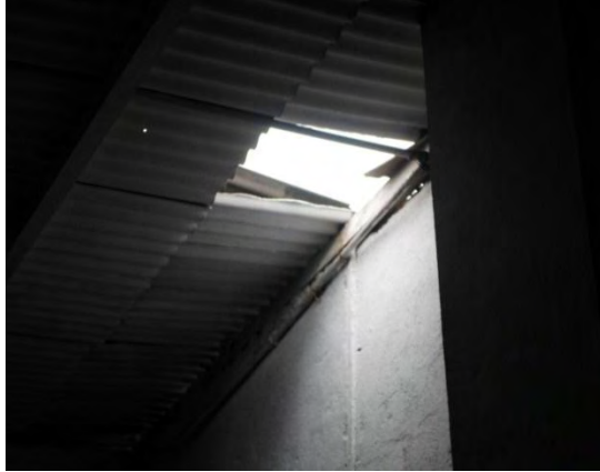
Figura 4. Abertura grande en el techo del área de procesos.
