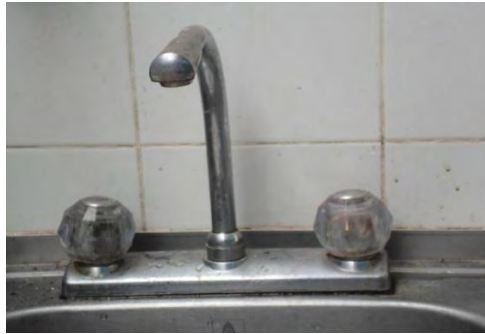
Figura 14. Grifo de compresión en el área de empaque.
