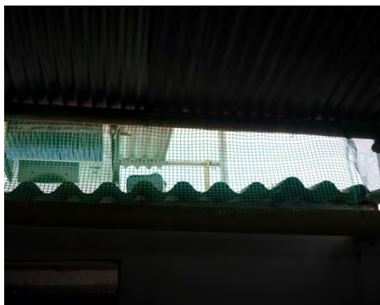
Figura 3. Desnivel de gran tamaño entre los techos del laboratorio y zona de lavado de cantinas.
