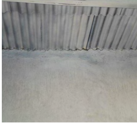
Figura 19. Sellamiento de todas las aberturas entre el techo y limite superior de las paredes.
