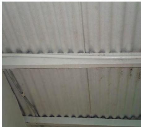
Figura 18. Renovación de techados del área de procesos.
