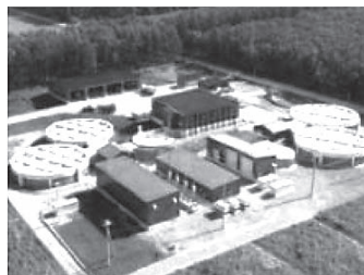
瓜幕バイオガスプラントの全景
