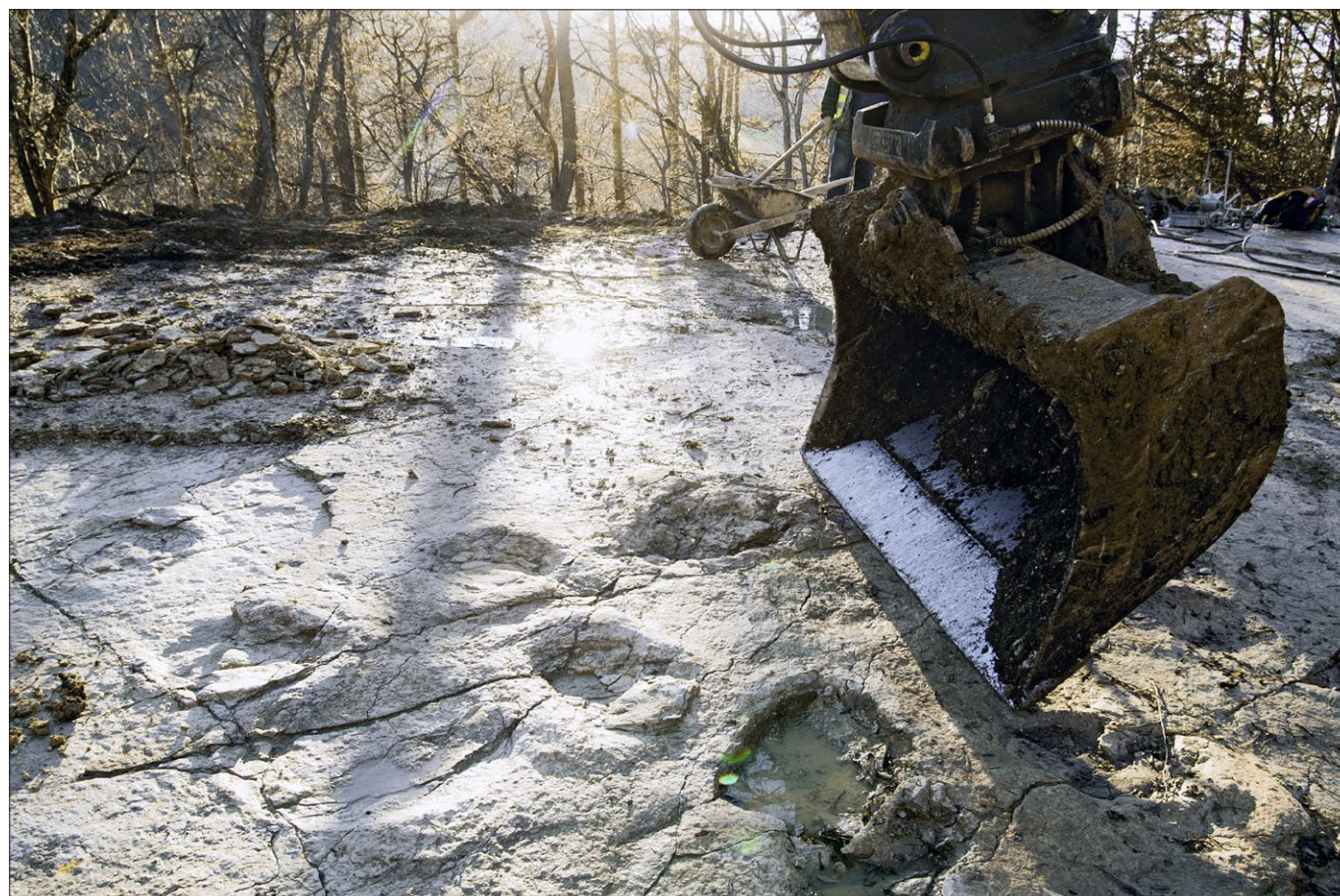
Décapage machine pour observer les couches sous-jacentes (PICT1712.jpg).
