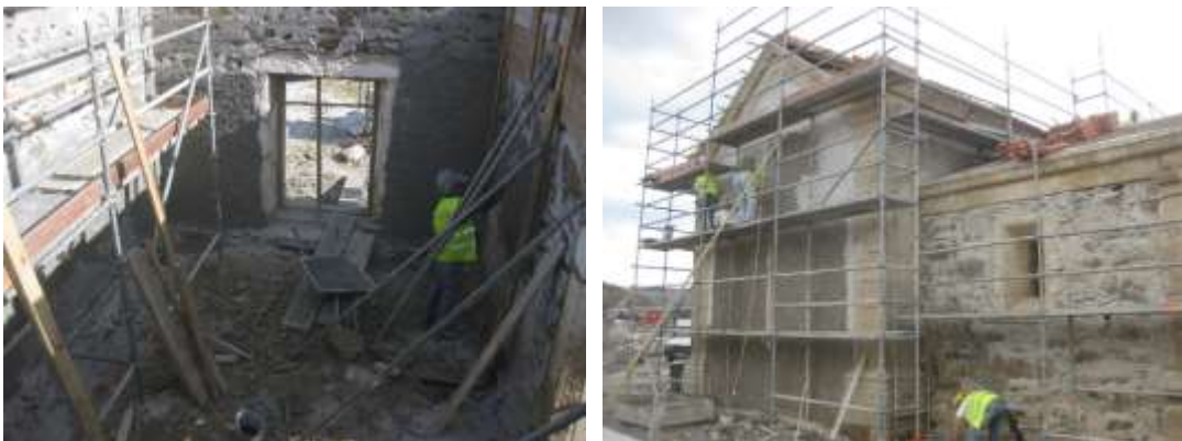
Figura 4-6 – Execução de rebocos
