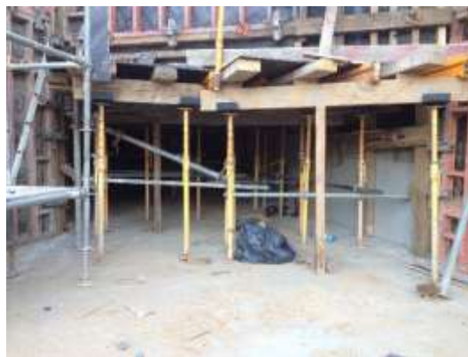
Figura 4-69 – Cofragem e armaduras colocadas para betonagem da 3ª fase
