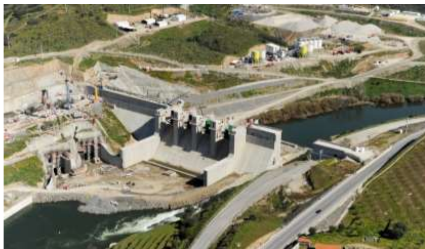
Figura 3-27 – Vista Geral – Acessos, Central de Betão, Estaleiros de Apoio
