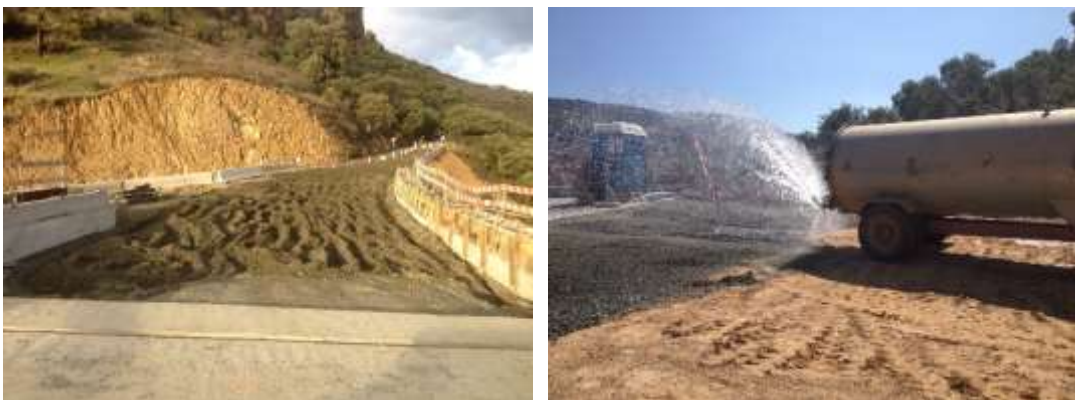
Figura 4-99 – Correção do teor de humidade no ABGE
