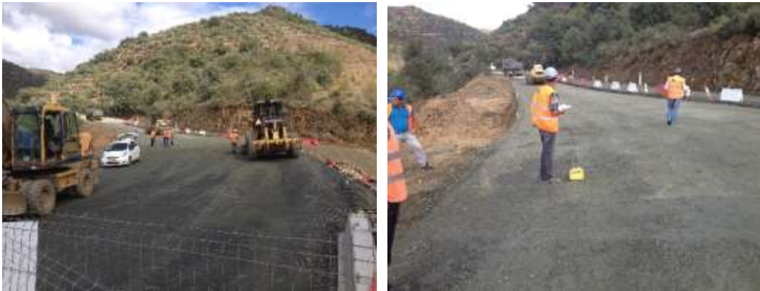
Figura 4-98 – Execução de camada de sub-base e base em ABGE
