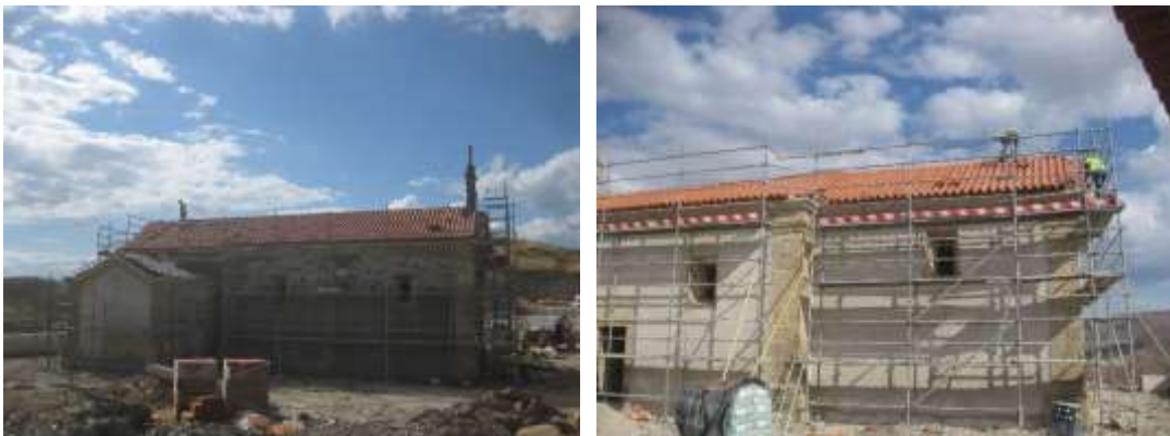
Figura 4-10 – Colocação de telha Lusa
