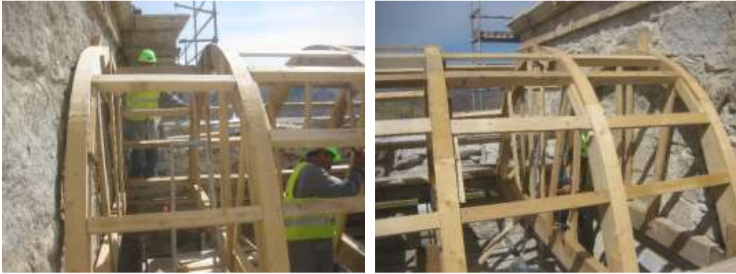
Figura 4-7 – Execução de cimbra da abóboda do altar-mor
