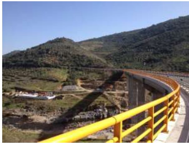
Figura 4-1 – Estaleiro de apoio à EN216 / EN217
