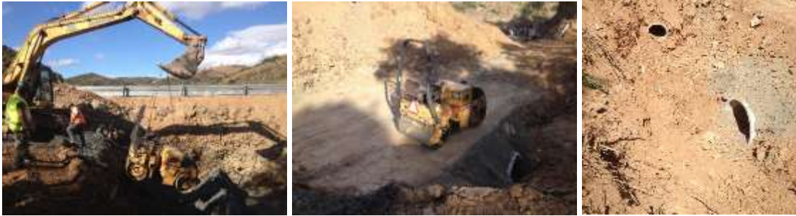
Figura 4-78 – Aterro da vala
