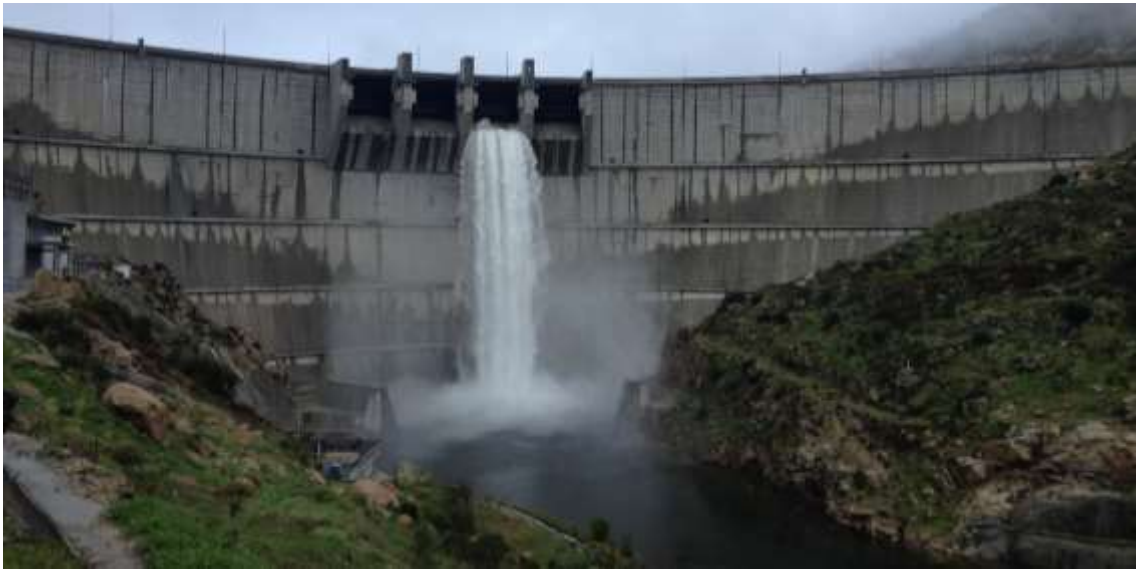
Figura 3-25 – Descarregador de Cheias a funcionar
