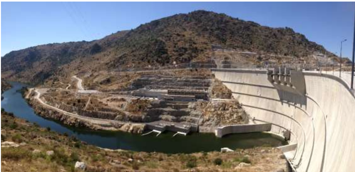
Figura 3-24 – Jusante Barragem – Central, Acessos, Subestação, Restituição, Bacia Dissipação
