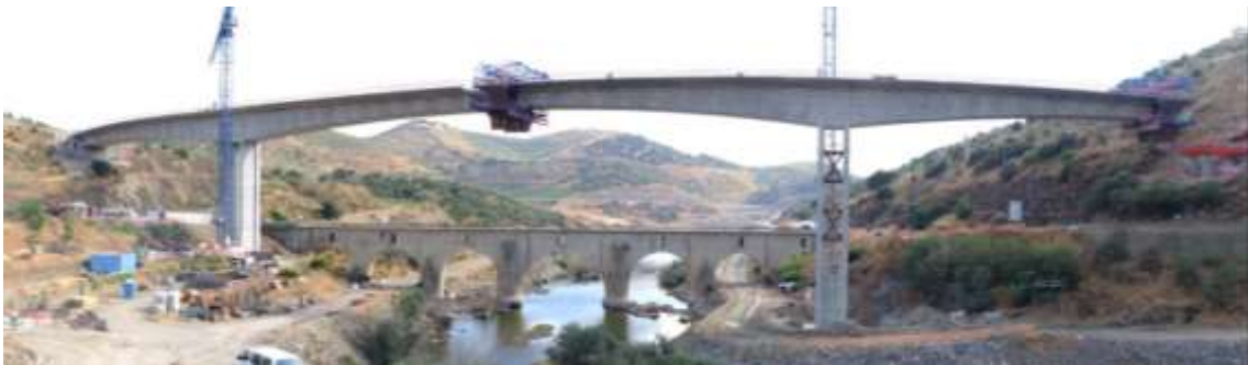
Figura 3-29 – Ponte s/ Rio Sabor na EN102
