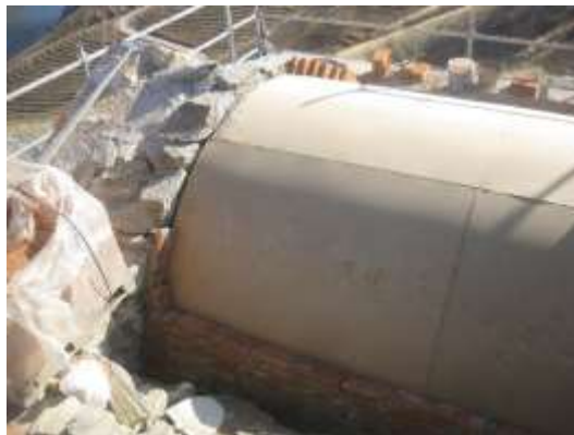
Figura 4-8 – Execução de abóboda em tijolo maciço
