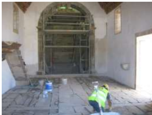
Figura 4-11 – Colocação de lajeado em granito
