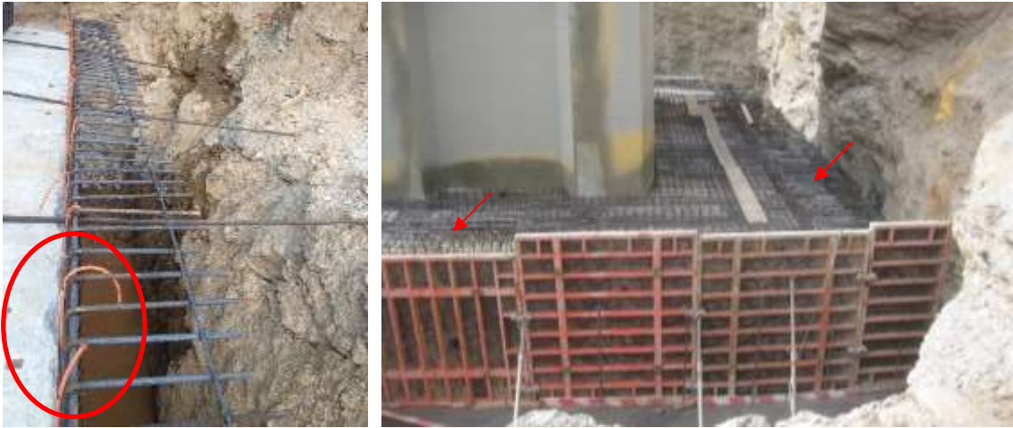
Figura 4-31 – Mangueira para injeção
