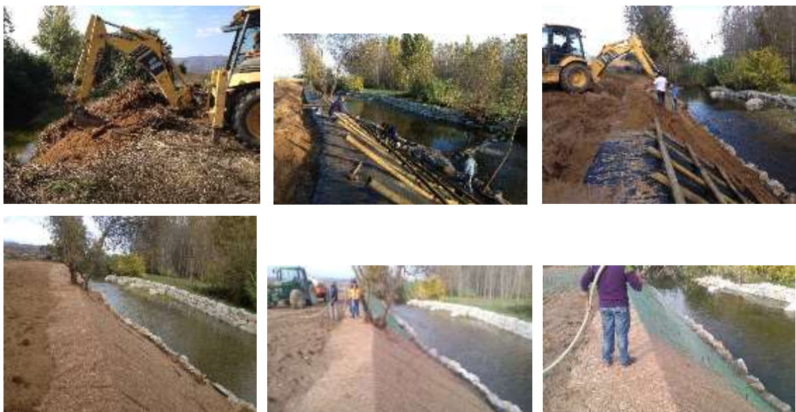
Figura 4-54 – Execução de proteção de margens com grades de troncos
