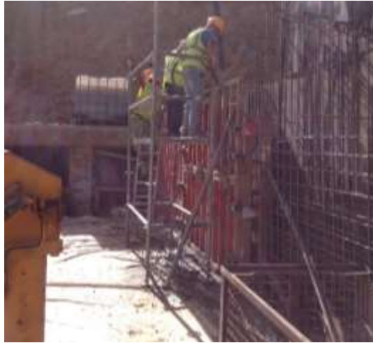
Figura 4-66 – Betonagem da 2ª fase
