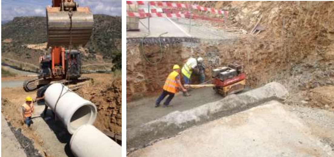
Figura 4-94 – Execução de passagem hidráulica
