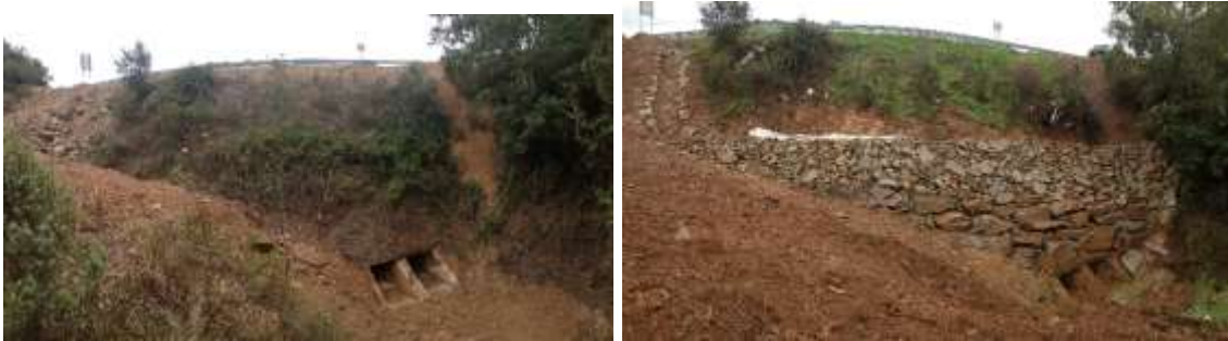
Figura 4-76 – Talude a montante da PH
