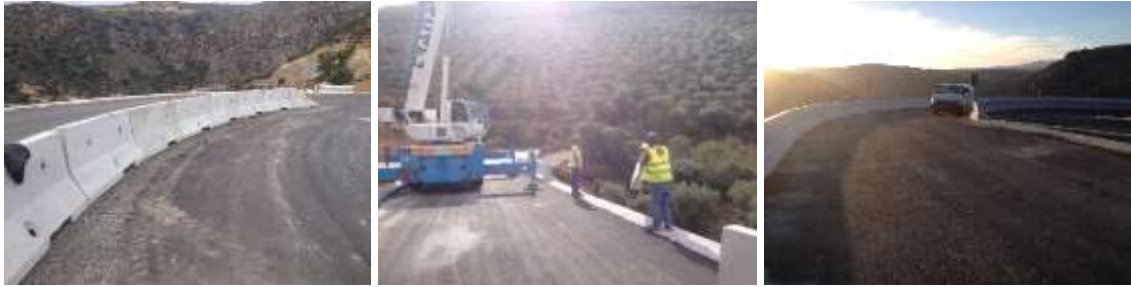
Figura 4-105 – Execução de guardas de segurança em perfis de betão
