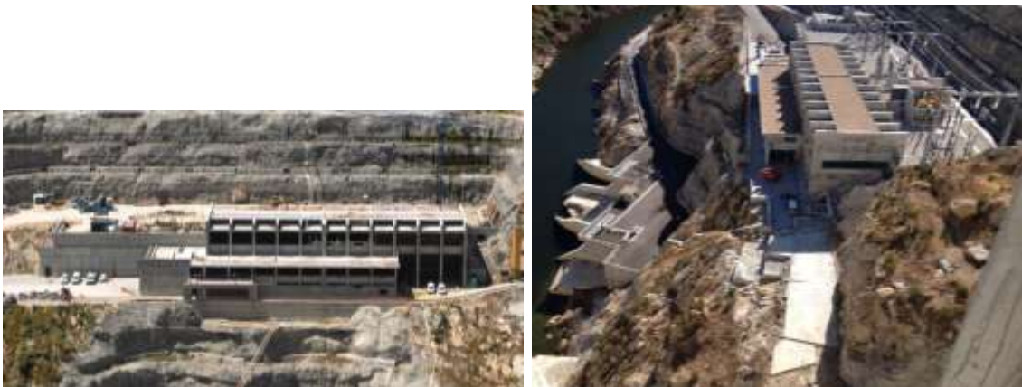
Figura 3-19 – Central e Subestação
