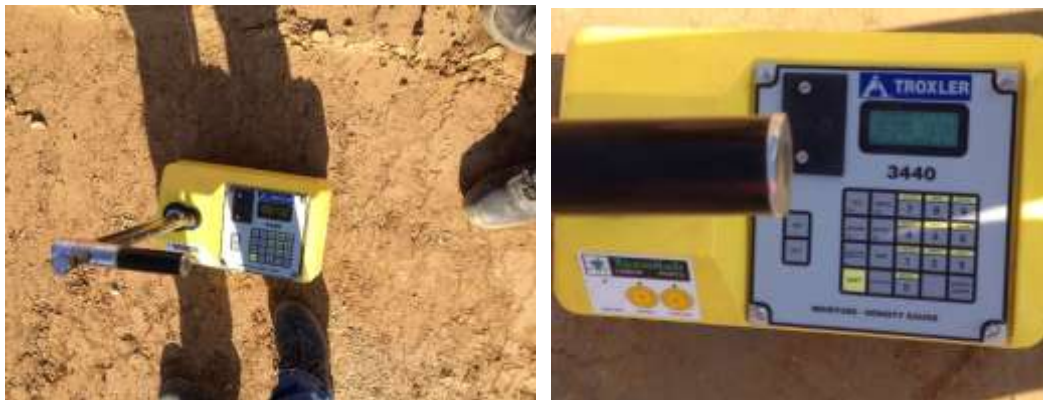
Figura 4-93 – Ensaio de compactação com gamadensímetro
