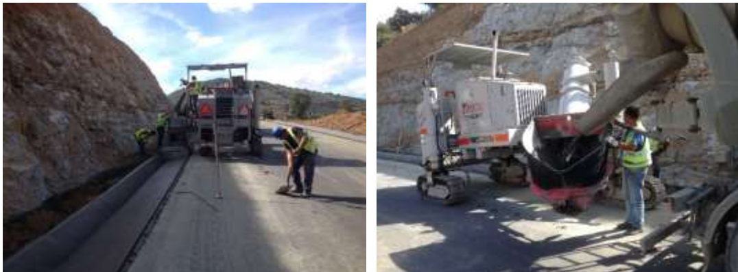
Figura 4-100 – Execução de valetas de plataforma
