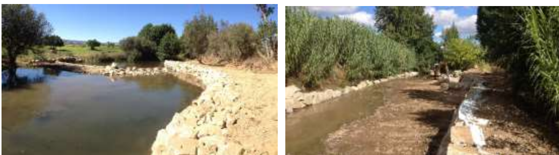
Figura 4-51 –Proteção de margens
