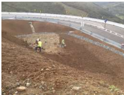
Figura 4-110 – Colocação de terra vegetal
