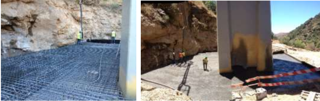
Figura 4-39 –Betonagem da 3ª fase
