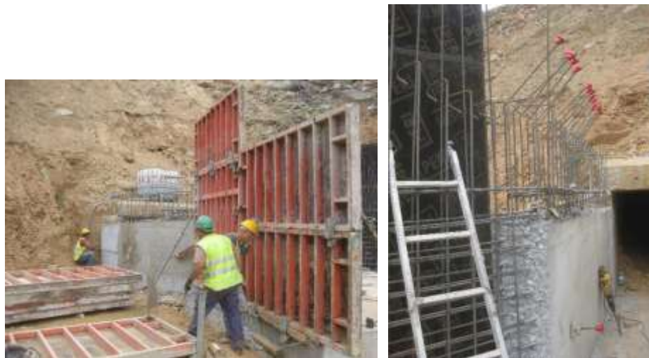
Figura 4-67 – Cofragem da 3ª fase
