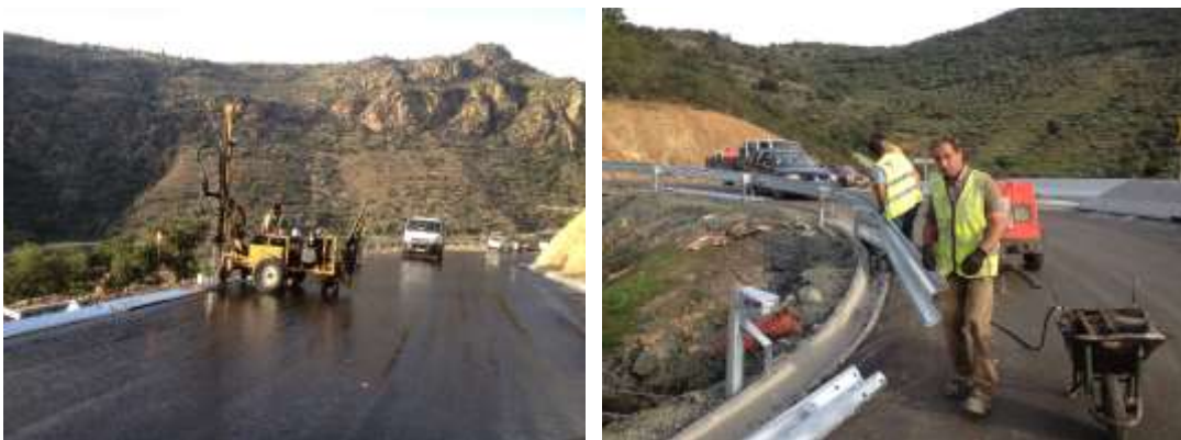
Figura 4-104 – Execução de guardas de segurança em perfis metálicos
