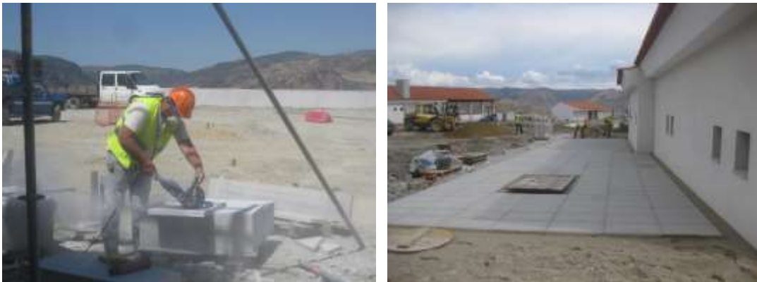
Figura 4-17 – Colocação de lajetas de betão
