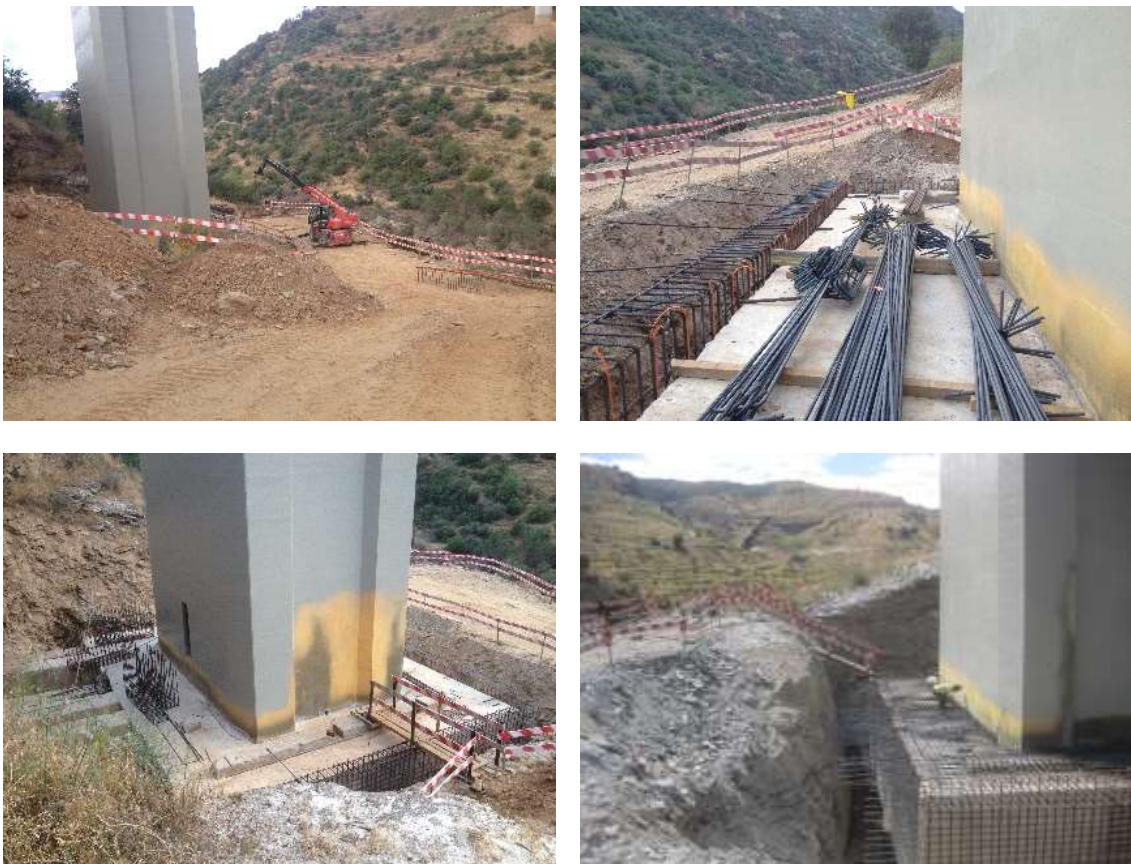
Figura 4-30 – Colocação de armaduras
