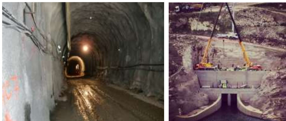
Figura 3-12 – Derivação Provisória do Rio Sabor.
