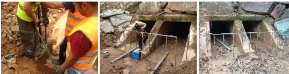
Figura 4-77 – Colocação de varões em aço inox
