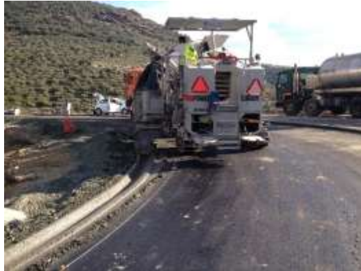
Figura 4-101 – Execução de valetas de bordadura in-situ
