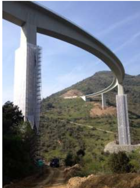
Figura 4-28 – Ponte s/ o Rio Sabor – Proteção dos pilares em execução (abril 2014)
