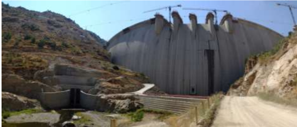
Figura 3-22 – Lado montante da Barragem em construção
