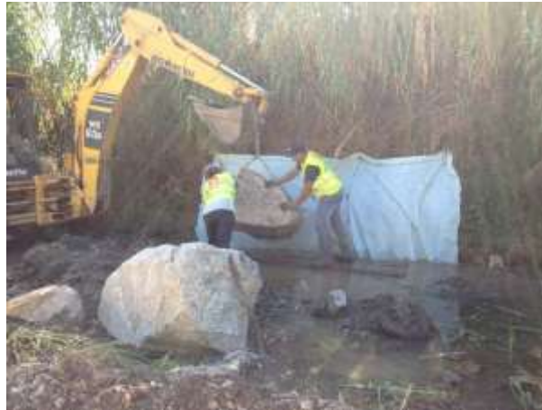
Figura 4-50 –Execução de Lunkers
