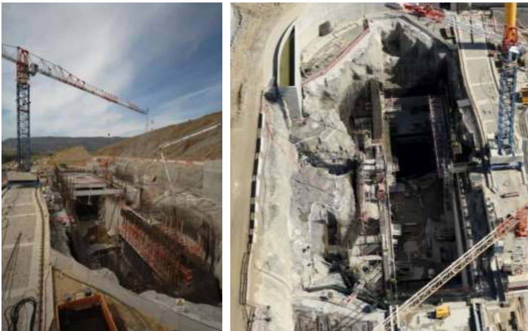
Figura 3-33 – Central e Subestação (Fase escavação e Estrutura)
