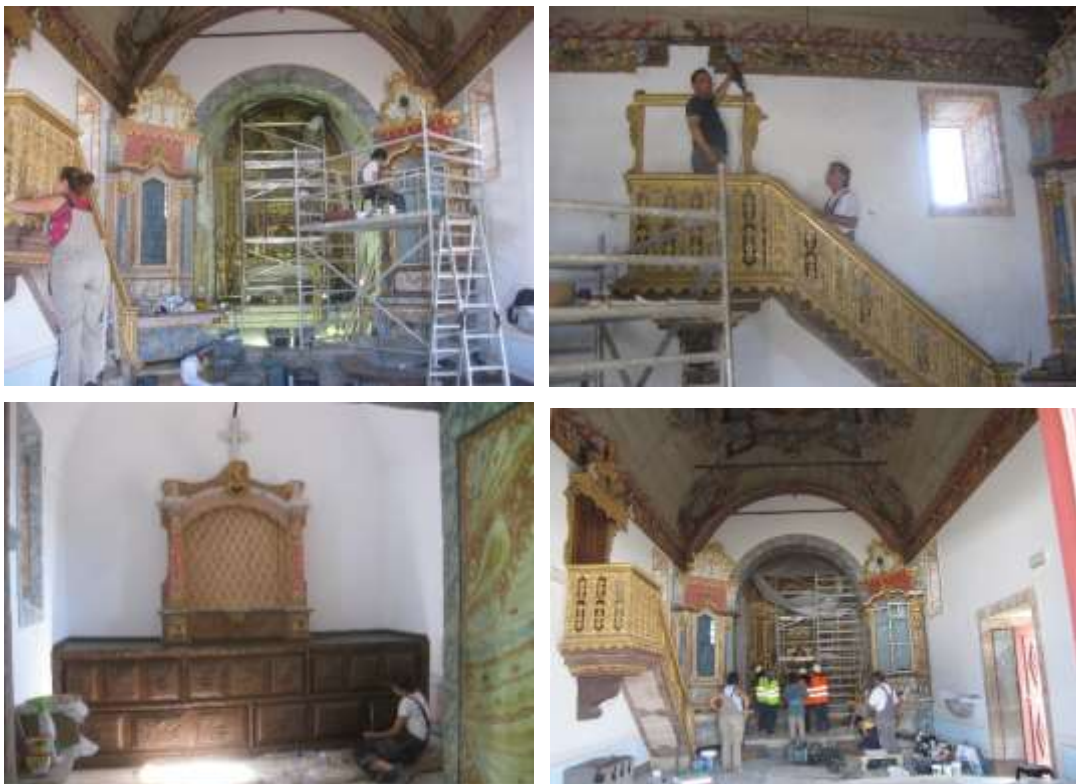
Figura 4-12 – Montagem de altares e frisos em madeira, com ornamentos dourados
