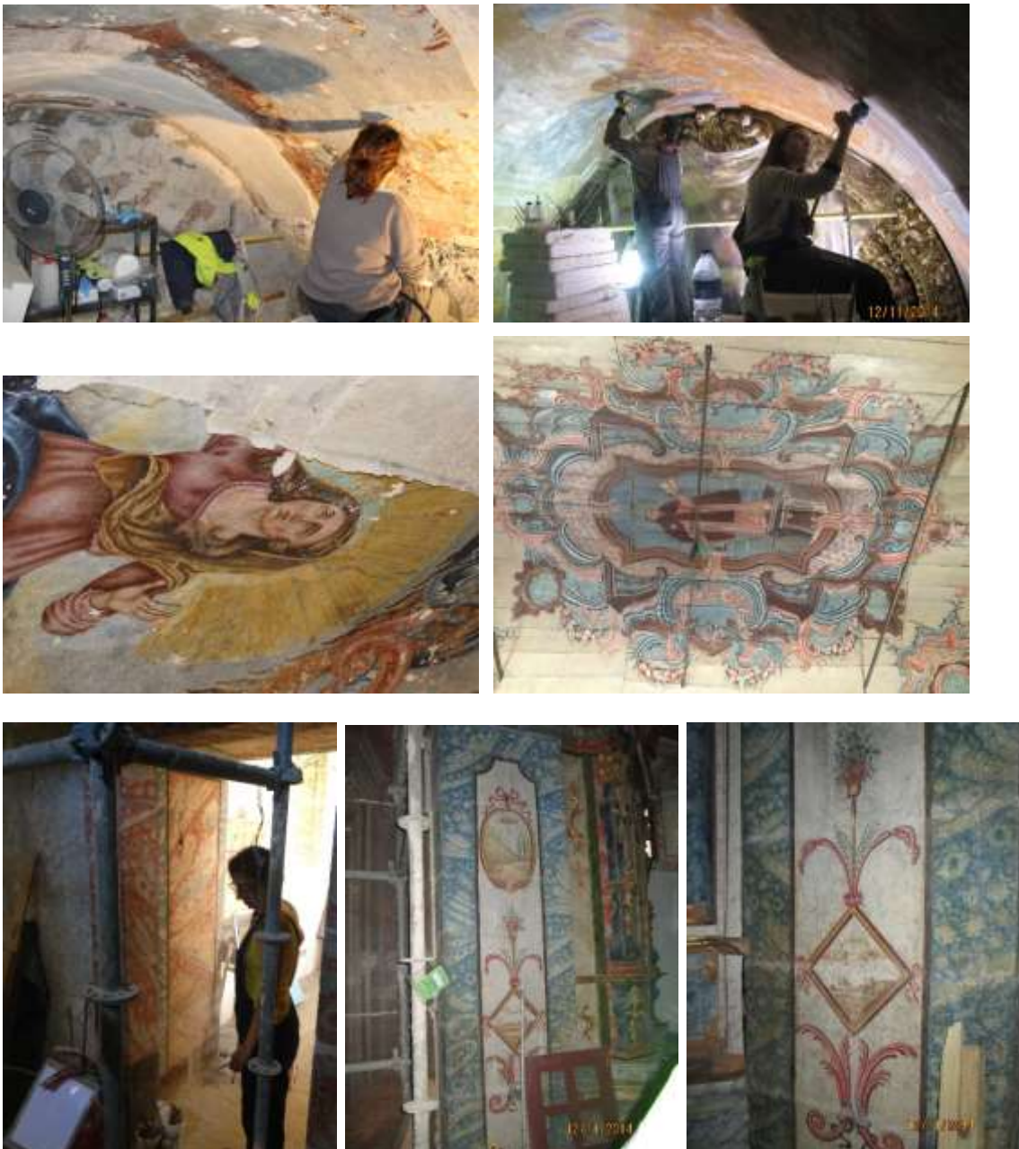
Figura 4-13 – Recuperação de pinturas em tetos, paredes e cantarias
