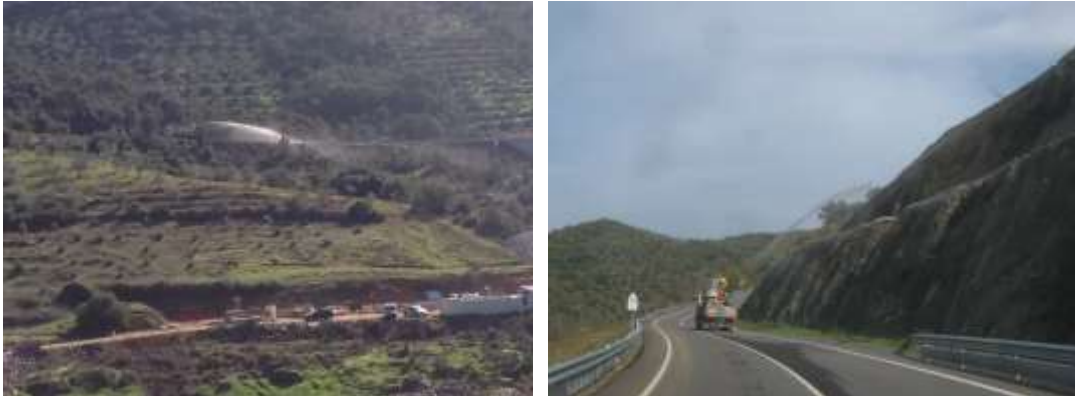
Figura 4-111 – Hidrossementeira
