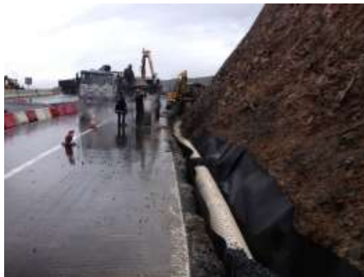
Figura 4-97 – Execução de dreno em coletor perfurado
