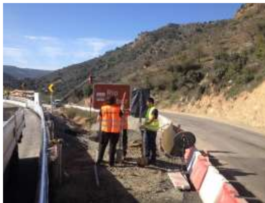
Figura 4-109 – Montagem de Sinalização
