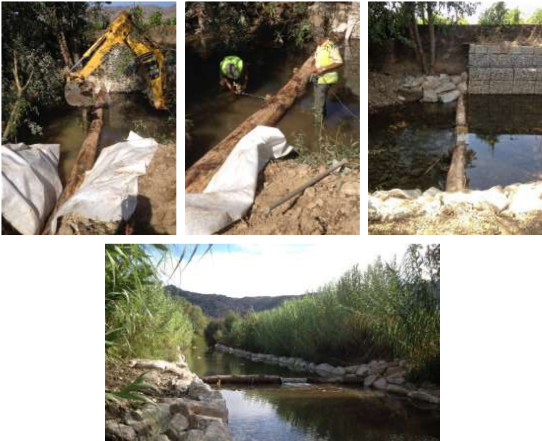
Figura 4-49 –Execução de açudes galgáveis em troncos
