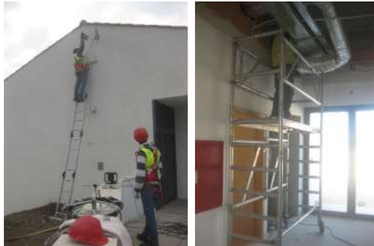
Figura 4-23 – Execução Instalações Elétricas
