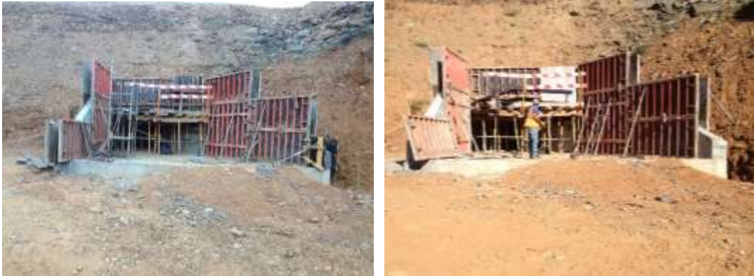
Figura 4-70 – Descobragem
