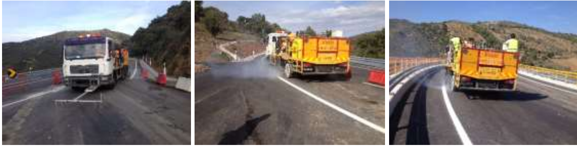
Figura 4-108 – Marcação de linhas contínuas
