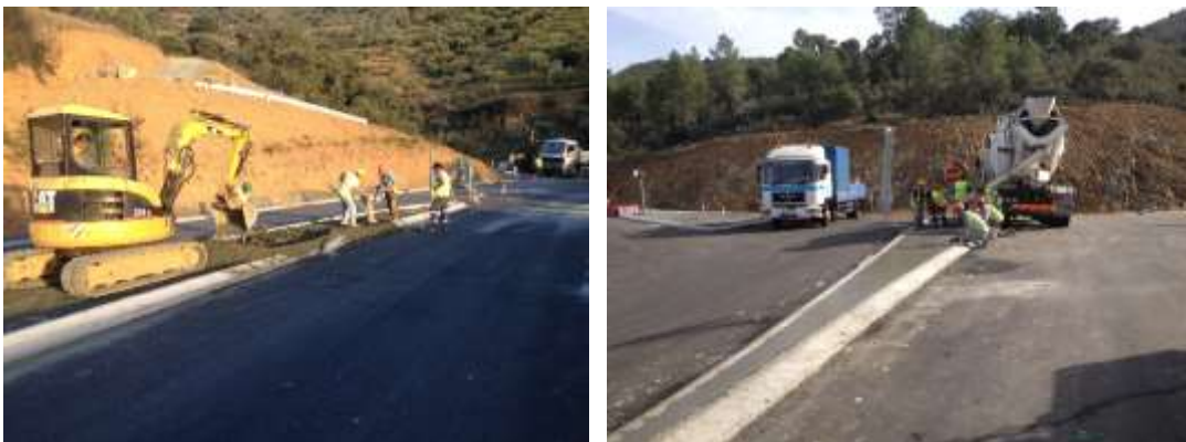
Figura 4-114 – Execução do interior das ilhas
