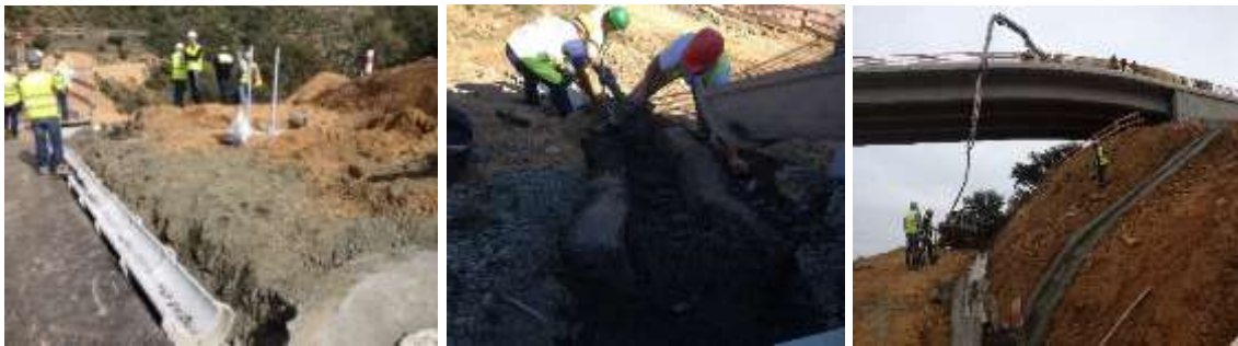
Figura 4-102 – Execução de valetas de bordadura e descidas de água em meias-manilhas de betão
