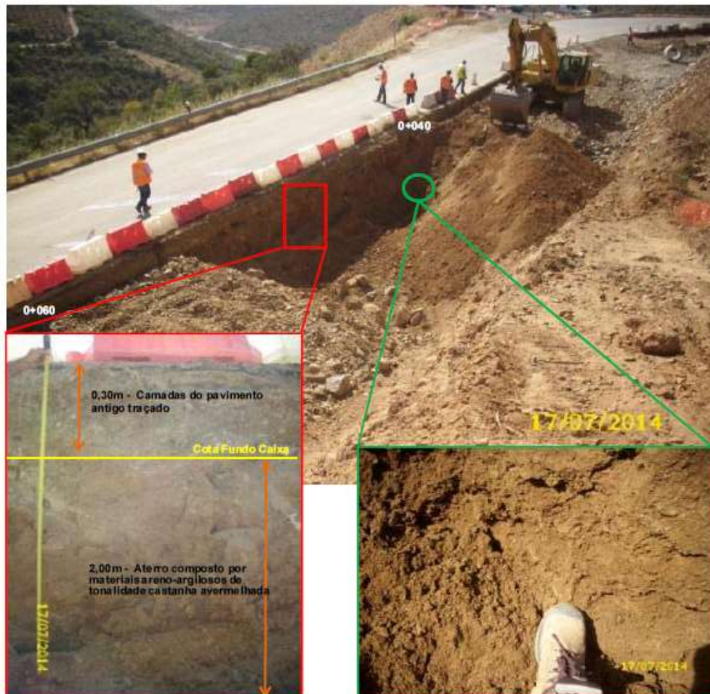
FIGURA 1 - Vista geral da zona de aterro (0+040 ao 0+060) e pormenor dos materiais areno-argilosos constituintes do aterro.
