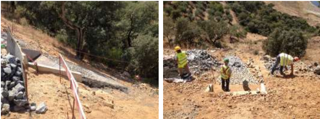
Figura 4-96 – Execução de boca de saída de passagem hidráulica
