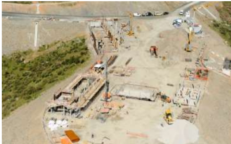
Figura 3-45 – Fase de Construção do novo Santuário de Santo Antão da Barca
