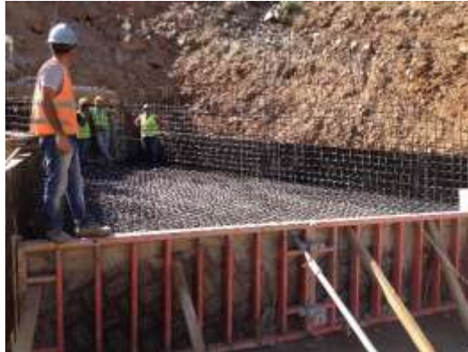
Figura 4-64 – Armadura e cofragem colocada
