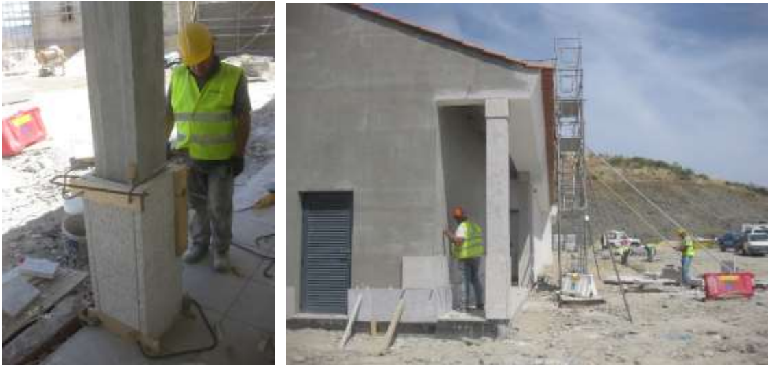
Figura 4-15 – Revestimento de paredes exteriores com granito
