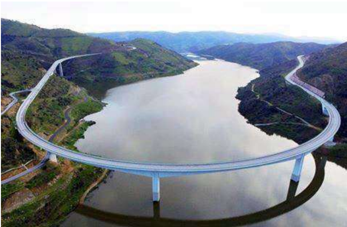
Figura 4-42 – Ponte s/ o Rio Sabor – Enchimento à cota 230 (dezembro 2015)
