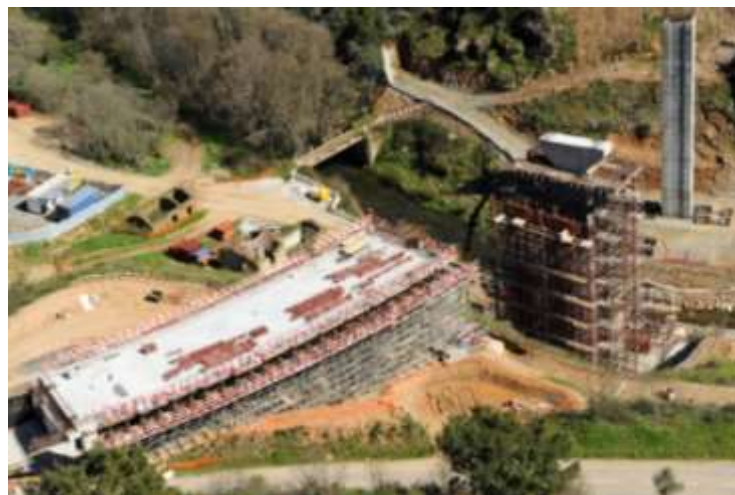
Figura 3-49 – Ponte sobre a Ribeira de Zacarias (em construção)
