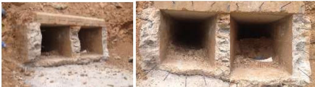
Figura 4-63 – Selagem de Varões à PH existente
