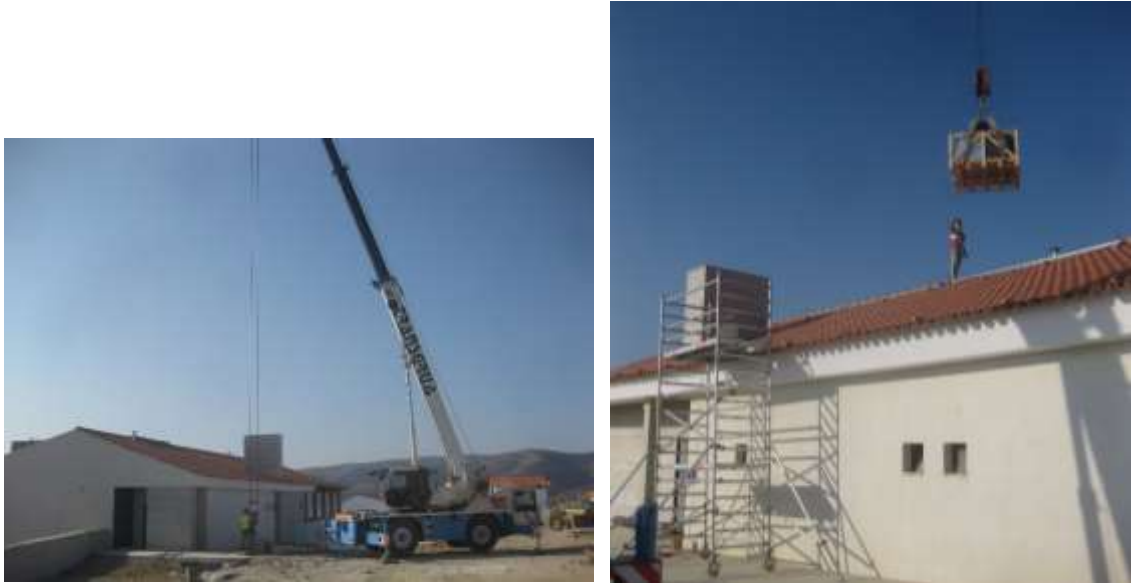
Figura 4-24 – Colocação Equipamentos AVAC na cobertura dos Edifícios
