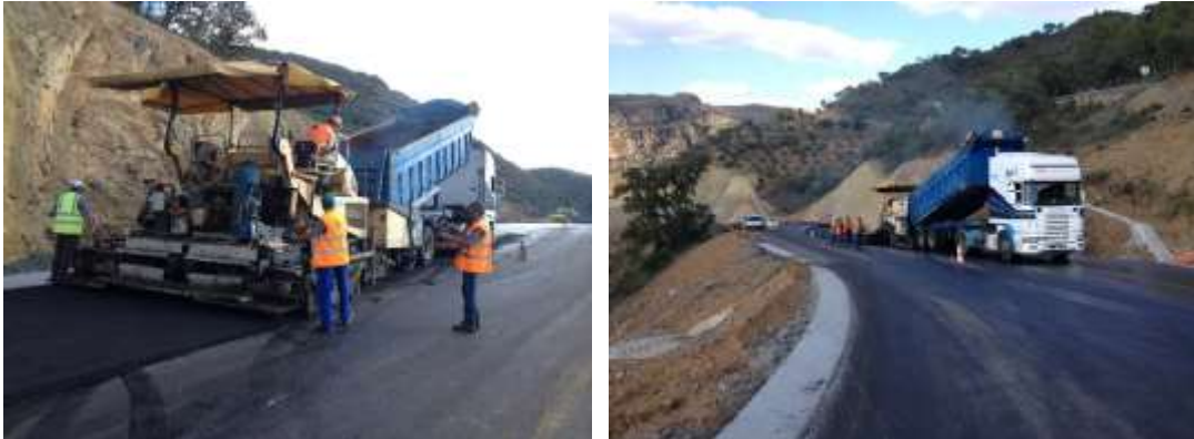
Figura 4-103 – Execução de camada de desgaste
