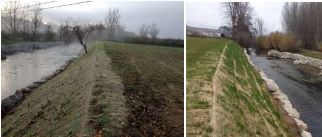
Figura 4-55 – Aspeto do talude após um mês da conclusão dos trabalhos
