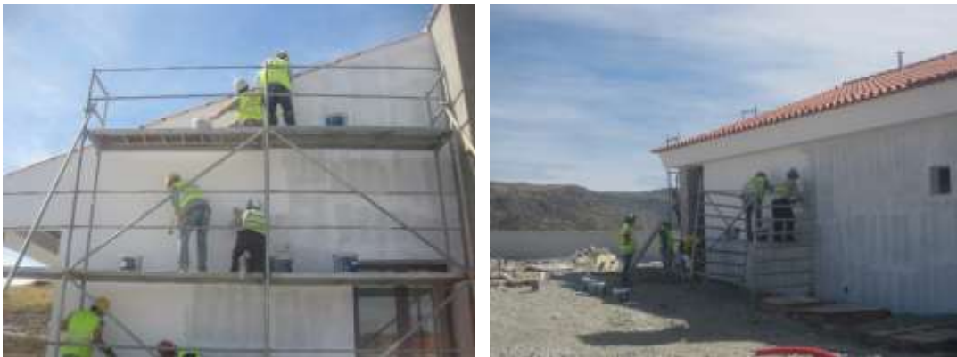
Figura 4-14 – Pintura de paredes exteriores
