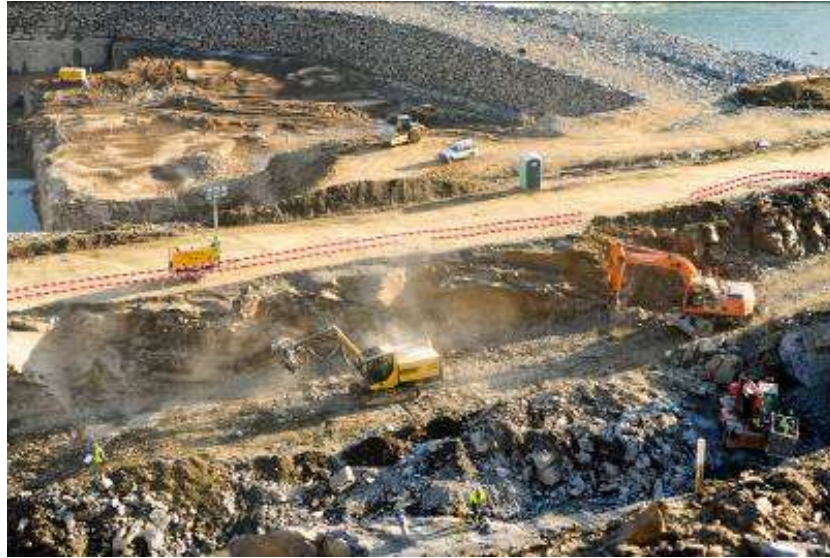
Figura 3-28 – Execução de Acessos
