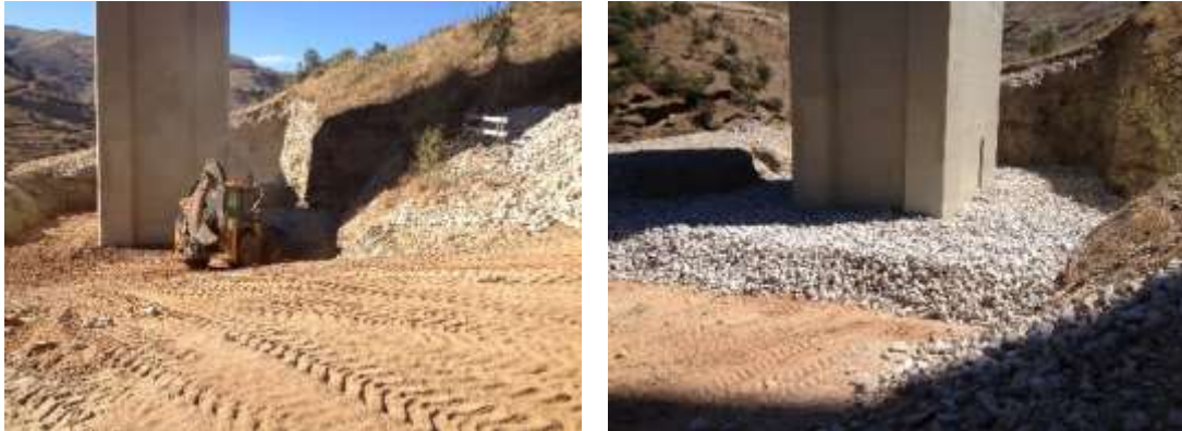
Figura 4-41 – Colocação de rachão sobre as sapatas
