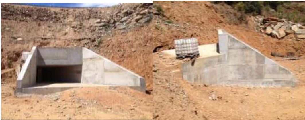
Figura 4-71 – Prolongamento da PH executado
