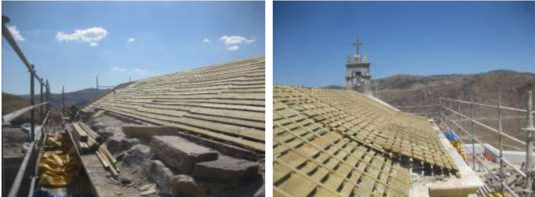
Figura 4-9 – Estrutura da cobertura em madeira
