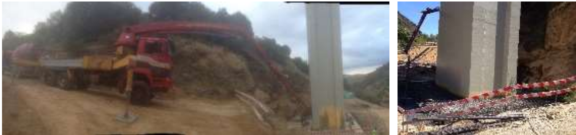
Figura 4-36 – Betonagem da 1ª fase e 2ª fase
