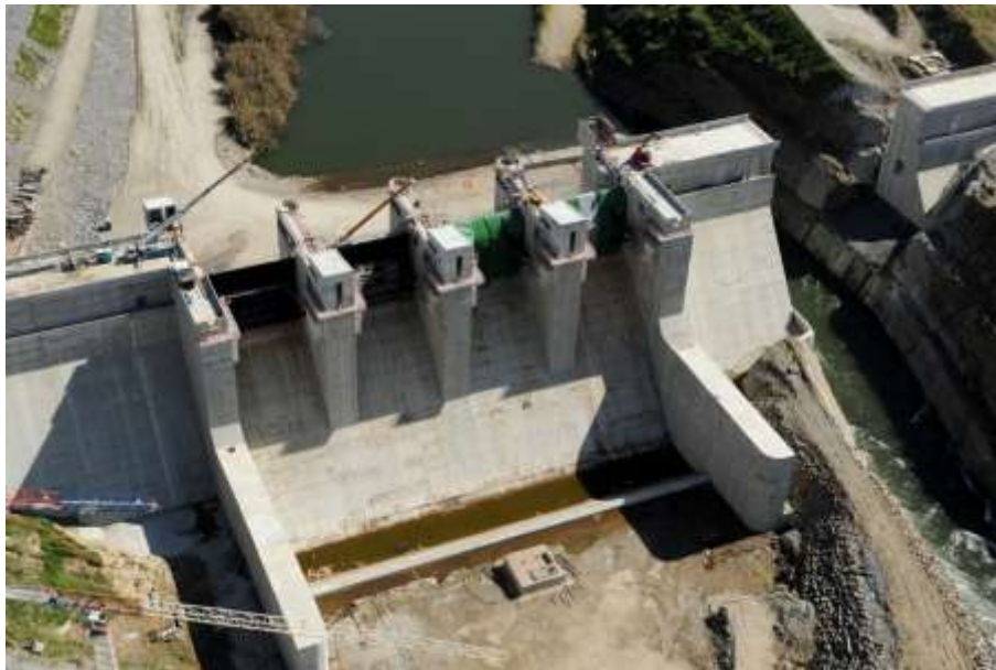
Figura 3-36 – Barragem (com um bloco por executar) e Bacia de Dissipação
