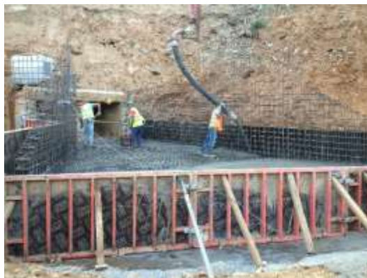
Figura 4-65 – Betonagem da 1ª fase
