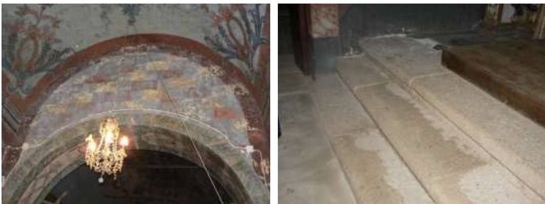
a) Pedras policromadas do Arco Triunfal b) Degraus de pedra junto ao altar da capela-mor
