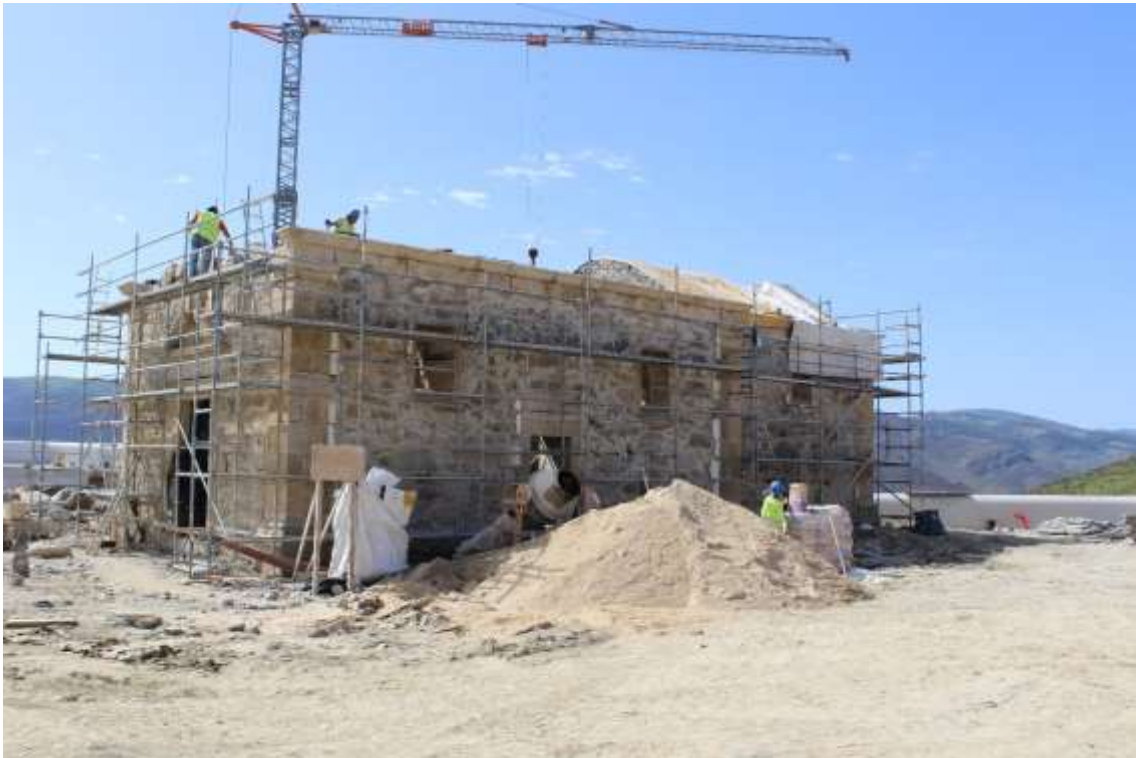
Figura 4-5 – Capela em construção
