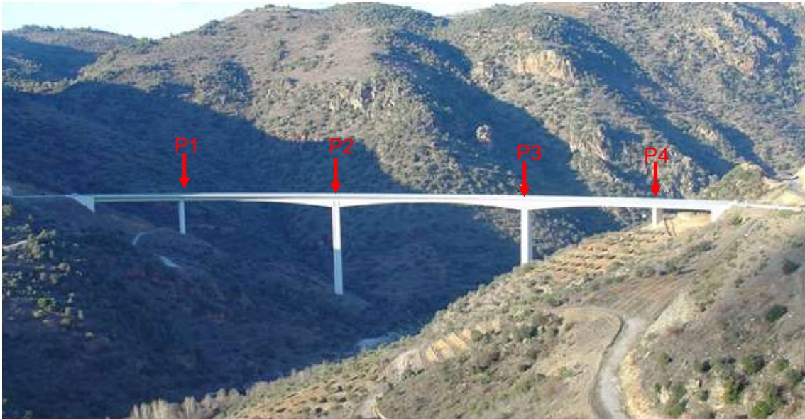
Figura 4-27 – Vista da Ponte Sobre o Rio Sabor
