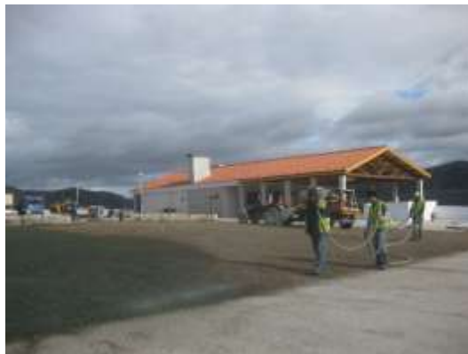
Figura 4-21 – Execução de hidrossementeira
