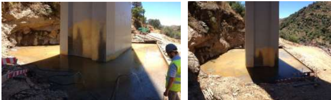
Figura 4-40 –Cura do betão
