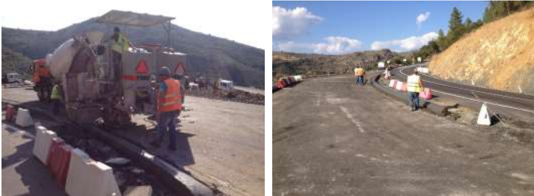
Figura 4-113 – Execução de lancil
