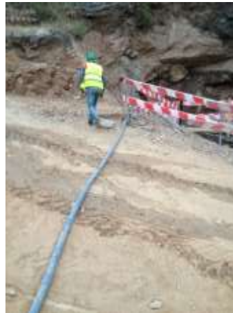
Figura 4-32 – Retirada de água da zona de trabalhos
