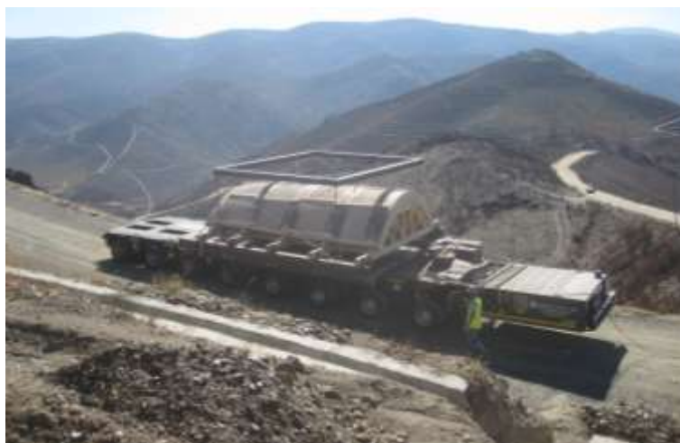
Figura 3-46 – Transladação da Abóbada da Capela de Santo Antão da Barca
