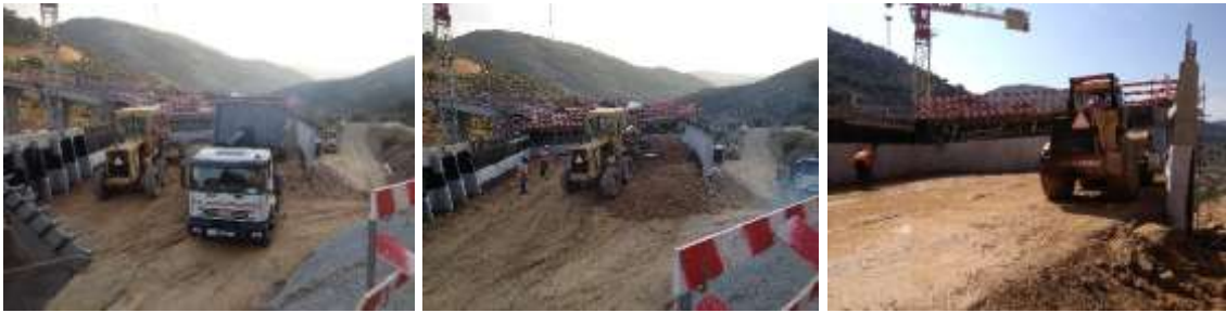
Figura 4-92 – Execução de aterro
