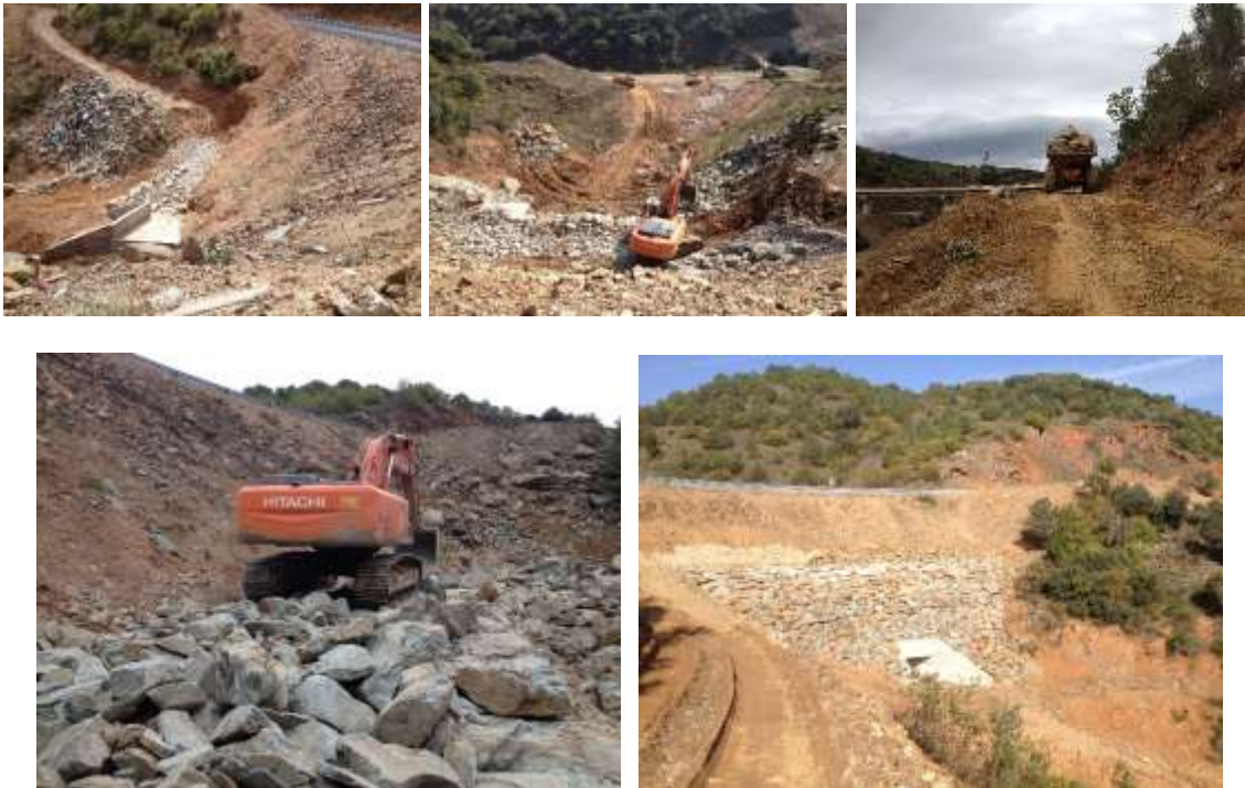
Figura 4-75 – Execução de proteção de talude
