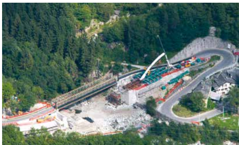
4. La costruzione del ponte ANAS a Gallivaggio (SO)
