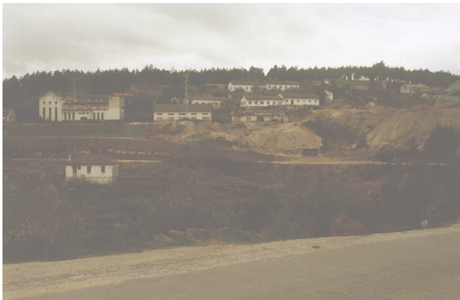
Foto 2.3 - Vista geral da escombeira, das instalações e bairro Mineiro
