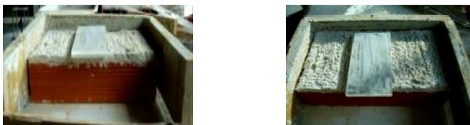
Figura 20 – Colocação das placas acrílicas sobre a 1ª camada de emboço.
