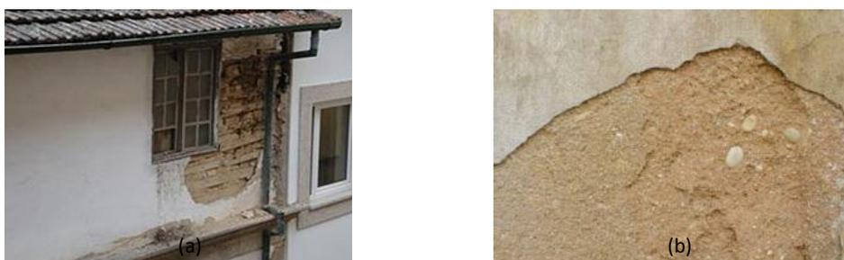
Figura 7 – (a) Destacamento do reboco na fachada de um edifício antigo; (b) Perda de coesão da argamassa de reboco.
