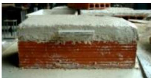
Figura 21 – Execução da 2ª camada de emboço.
