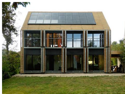
Figura 11: Edifício solar passivo com sistema de ganho direto (Fonte: (Creat. H. Id., 2012))
