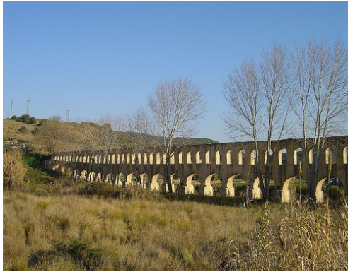
Figura 1.1- Aqueduto no Concelho de Torres Vedras.
