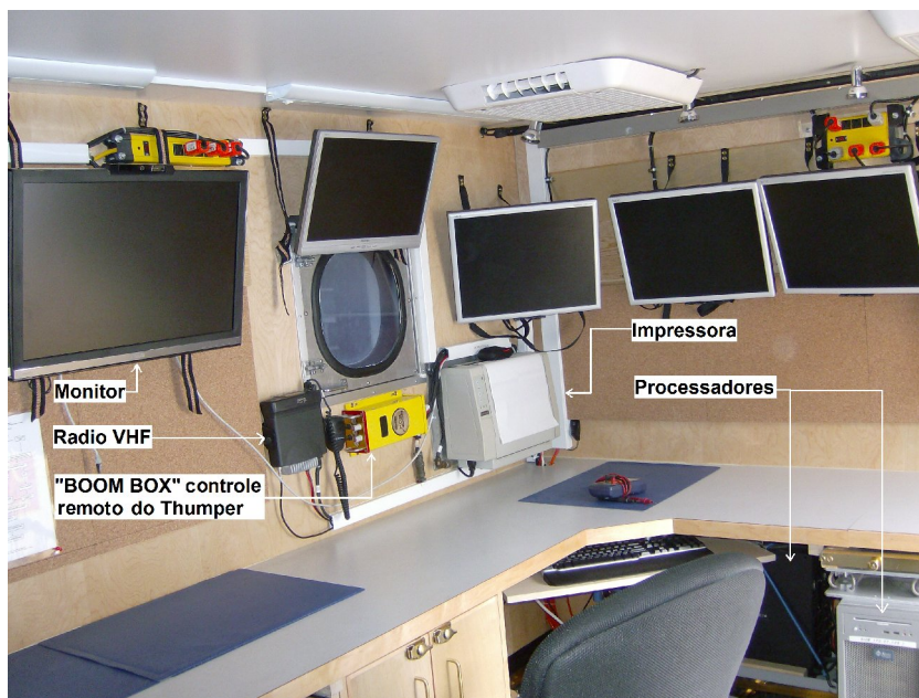
Figura 4.18- Equipamentos montados no interior da Dog House .
