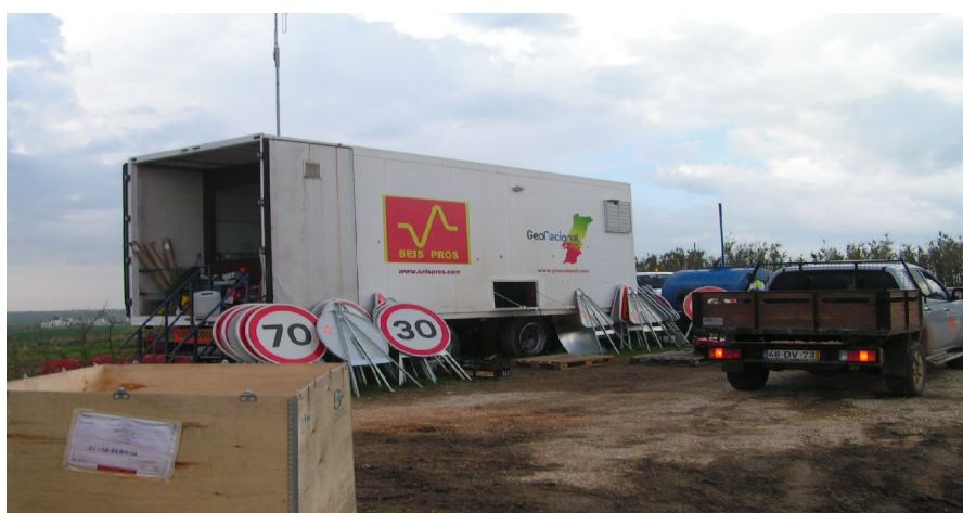
Figura 4.1- Centro de operações “ Staging ” na área de Torres Vedras.
