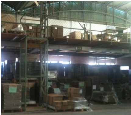
Figura 20 – Armazém 5009 no início do projecto
