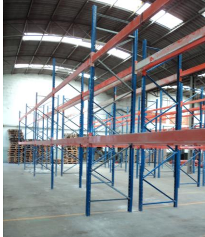
Figura 32 – Construção do armazém em fase final
