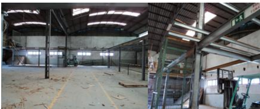
Figura 30 – Desmantelamento do 2º piso do armazém
