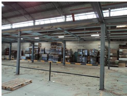
Figura 29 – Estrutura metálica do armazém
