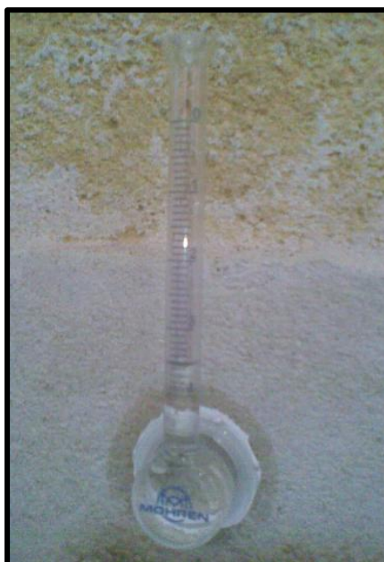
Figura 30. Ensaio de absorção de água a argamassa em parede de adobe (Matos, 2012)
