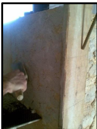
Figura 16. Aplicação da camada de chapisco na parede de adobe (Matos, 2012)
