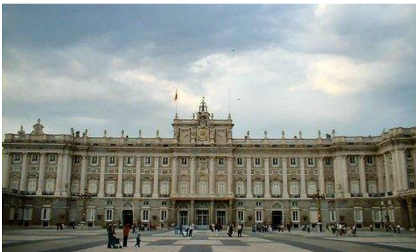
Ilustração 10 – Palácio Real de Espanha (fachada)
