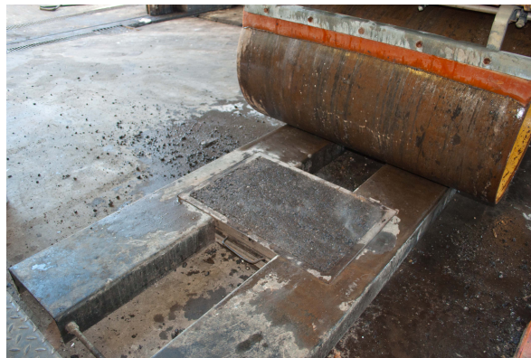
Figura 26. Molde e compactação de laje.
