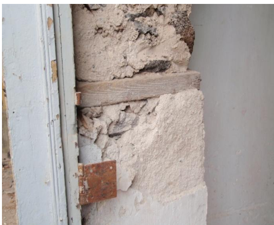
Figura 45. Argamassa de revestimento interior, Residência Municipal
