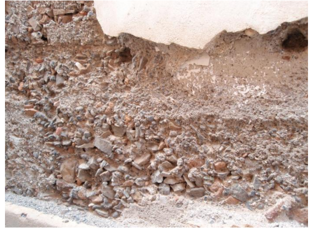
Figura 34. Revestimento interior do Fortim d'El Rei
