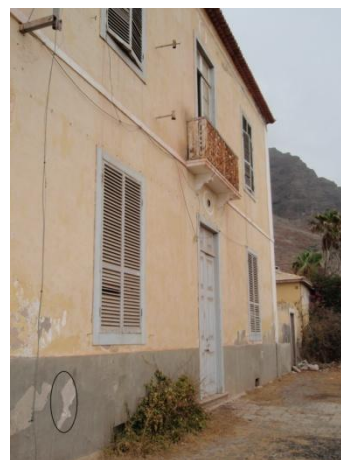
Figura 46. Localização da recolha de reboco exterior, Residência Municipal
