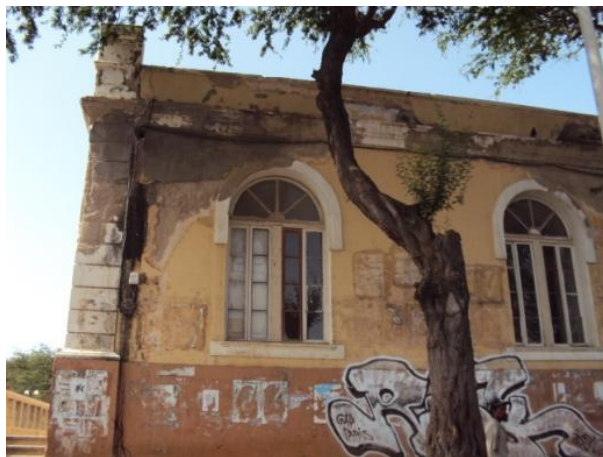
Figura 6. Exemplos de trabalho de reabilitação com argamassa à base de cimento, Liceu Velho, São Vicente
