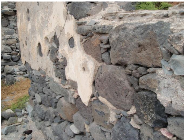
Figura 49. Revestimento interior, Sinagoga
