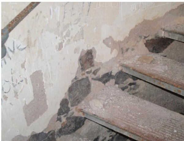
Figura 41. Revestimento interior do Farol (CV - SAPL-FR1)
