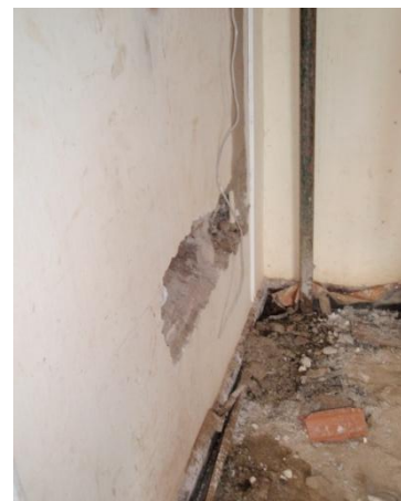
Figura 39. Revestimento Interior do Antigo Consulado Inglês
