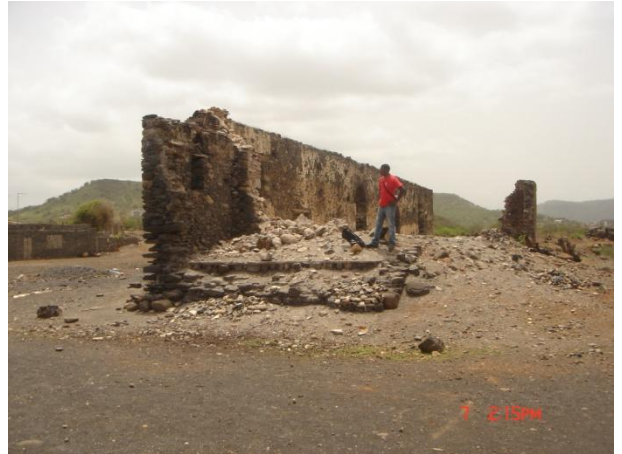
Figura 27. Revestimento Exterior, Igreja N. S a Da Luz
