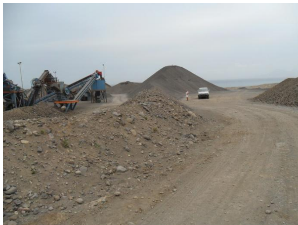
Figura 3. Britadeira, Porto Novo, Santo Antão
