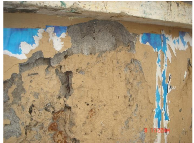
Figura 32. Revestimento exterior do Mercado da Assomada
