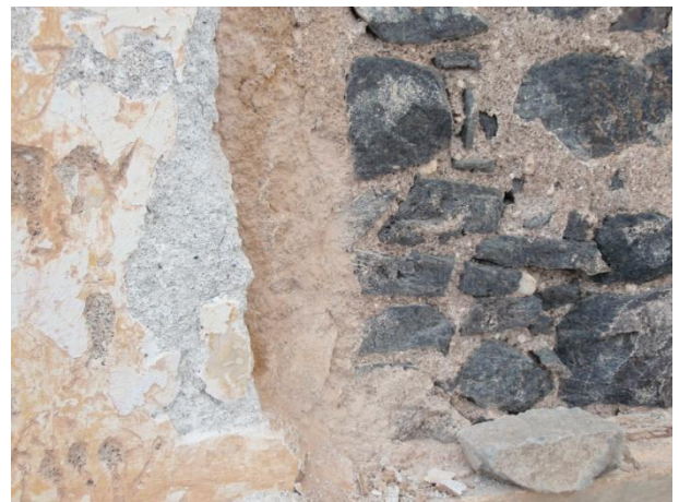
Figura 42. Revestimento Exterior do Farol (CV - SAPL-FR2)
