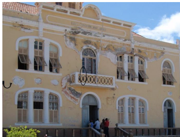
Figura 35. Indicação do local de recolha de reboco exterior, Liceu Velho
