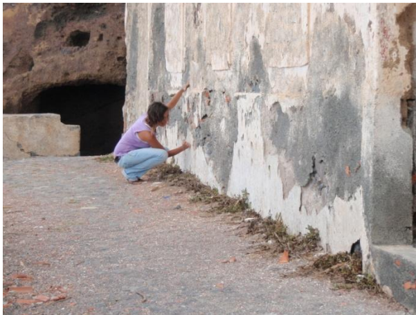
Figura 43. Recolha de argamassa do revestimento da Casa anexa ao Farol (CV - SAPL-CF2)
