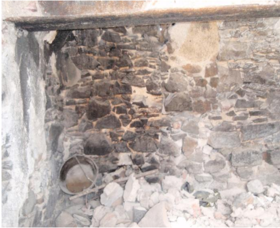
Figura 33. Revestimento interior da cozinha do Fortim d'El Rei
