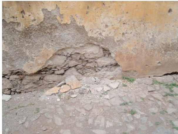
Figura 51. Revestimento exterior, Seminário de S. Nicolau (CV-RB-2)
