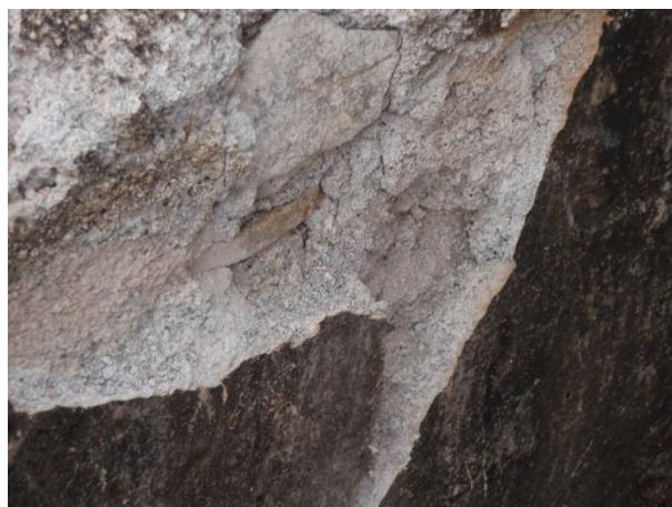
Figura 54. Revestimento exterior, Casa de Habitação, Lombinho, Ribeira Brava (CV-RB-3)
