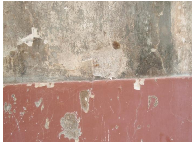
Figura 53. Revestimento exterior Ribeira Brava, São Nicolau (CV-RB-1)
