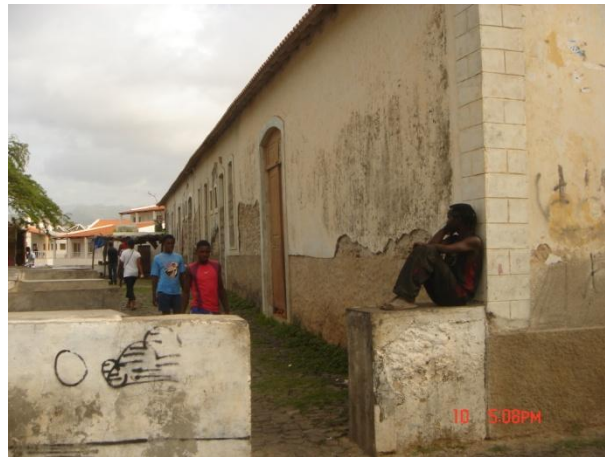
Figura 30. Revestimento exterior da casa da Alfândega do Tarrafal
