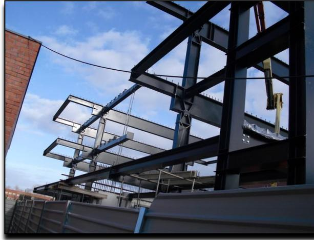
Figura 20: Estrutura metálica do edifício (Fonte própria, 2012)
