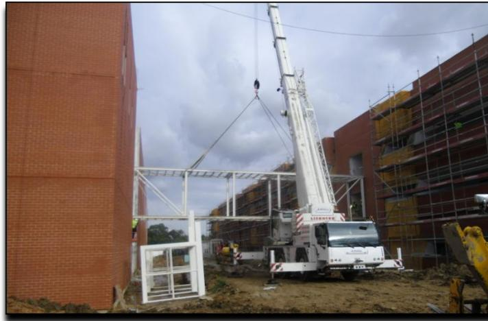
Figura 11: Colocação dos elementos pré-fabricados metálicos nos passadiços (Fonte própria, 2012)
