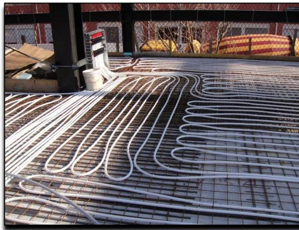
**Figura 22: Tubagem da geotermia apoiada na armadura da laje (Fonte própria, 2012)**
