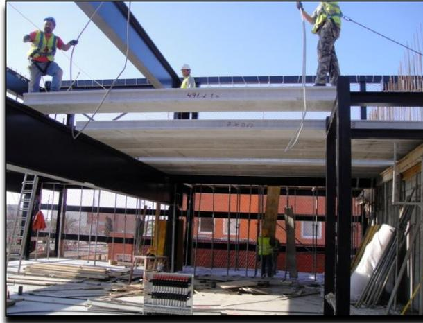
Figura 17: Montagem da laje alveolar em obra (Fonte própria, 2012)
