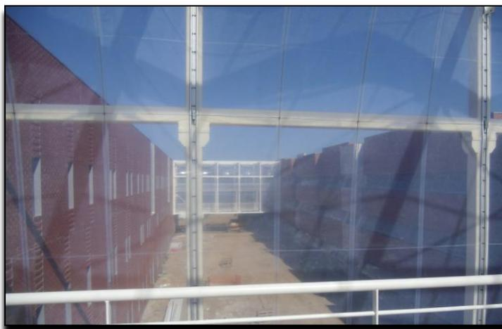
Figura 10: Transparência do ETFE (Fonte própria, 2012)
