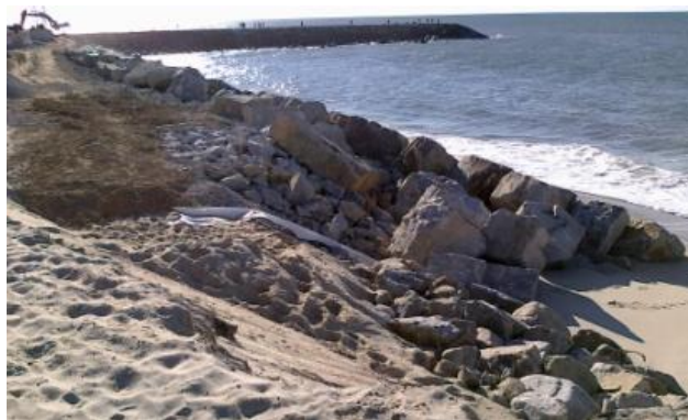
Figura 10: Fase construtiva de uma obra longitudinal aderente.
