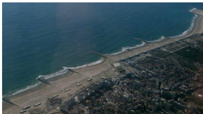
Figura 5: Aspecto da linha de costa com um campo de esporões.
