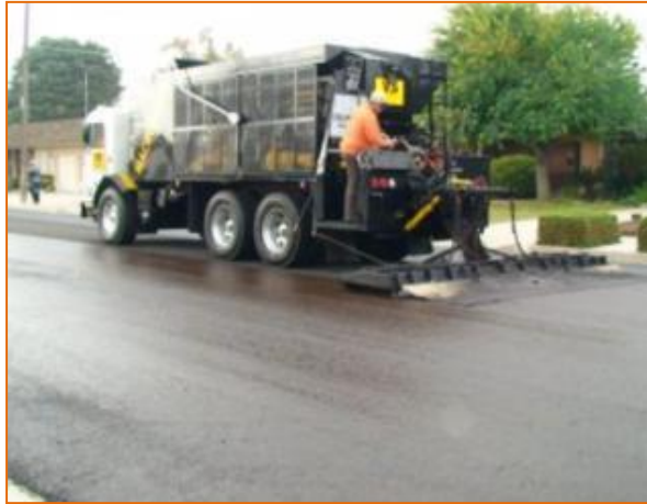
Figura 39. Aplicação de Slurry Seal (ISSA, 2011-c)
