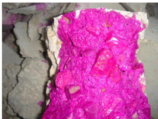
Figura 7.11. Provete de composição M1 aos 180 dias de idade sujeito ao ensaio de fenolftaleína após ensaio de compressão.
