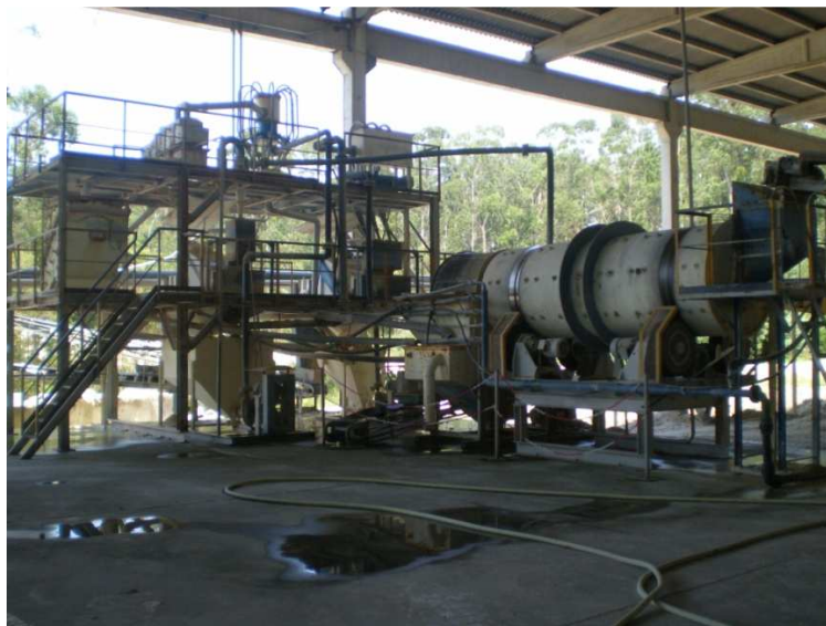
Figura 9: Mecanismo da lavagem 1 na empresa de extracção de caulinos da Mota Mineral em São Vicente de Pereira Jusã.
