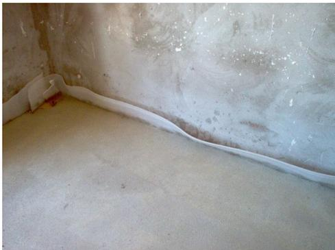
**Figura 16:** Manta resiliente de polietileno (acústica)
