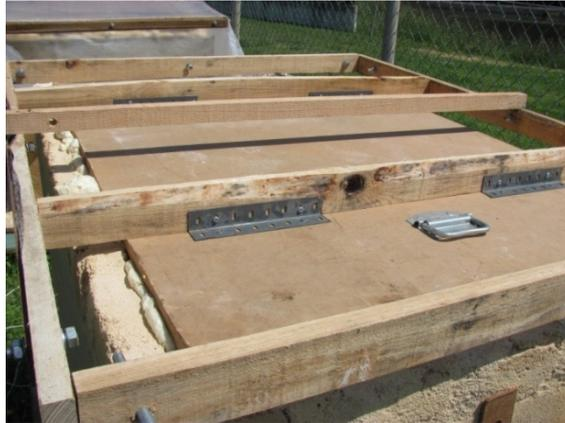
**Figura 26:** Estrutura em madeira para fixar a cobertura das células
