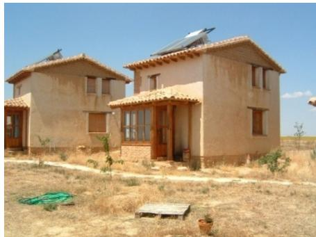
**Figura 11:** Casas novas em alvenaria de Adobe - Astúrias, Espanha [19]
