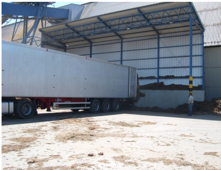
Figura 4.4: Fossa de descarga da biomassa externa.
