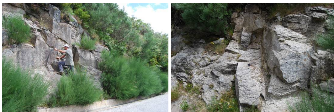
Figura 203 – Aspecto do ensaio esclerométrico nas descontinuidades do Painel 7 e pormenor de descontinuidades próximas (F 4-5 ), em maciço são a pouco alterado (W 1-2 ).
