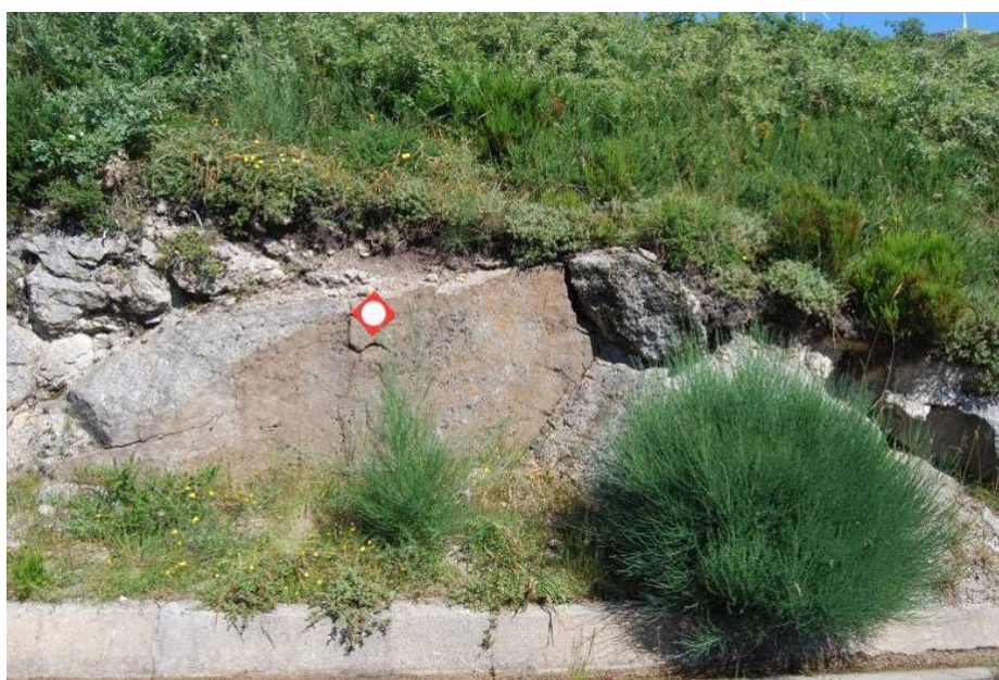
Figura 190 – Aspecto de um plano de falha registrado no panel 5 .
