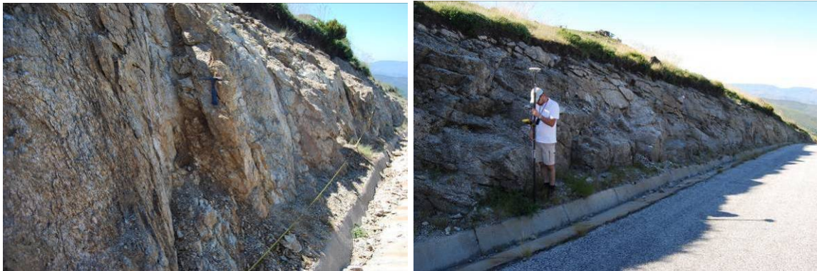
Figura 172 – Aspecto geral do Painel 1 , com destaque para uma falha com preenchimento de material argiloso, e georreferenciação do ponto inicial do Painel 1 com recurso a GPS.
