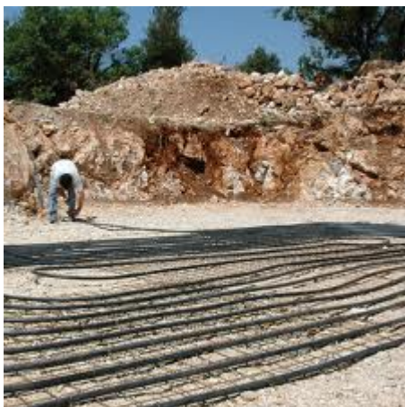
Figura 26. Colocação de sondas geotérmicas (Fonte – Obras particulares)
