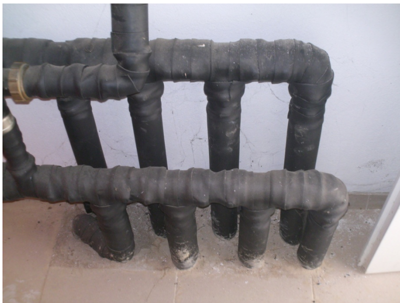
Figura 45. Saída da casa das máquinas
