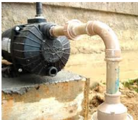
Figura 32. Captação em lençol freático (Fonte – www.ccc.com )
