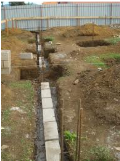
Figura 28. Abertura de sapatas com vigas de fundação (Fonte – Obras particulares)
