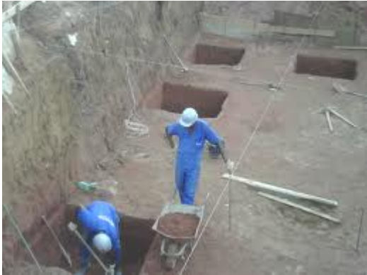
Figura 27. Abertura de sapatas isoladas (Fonte – Obras particulares)
