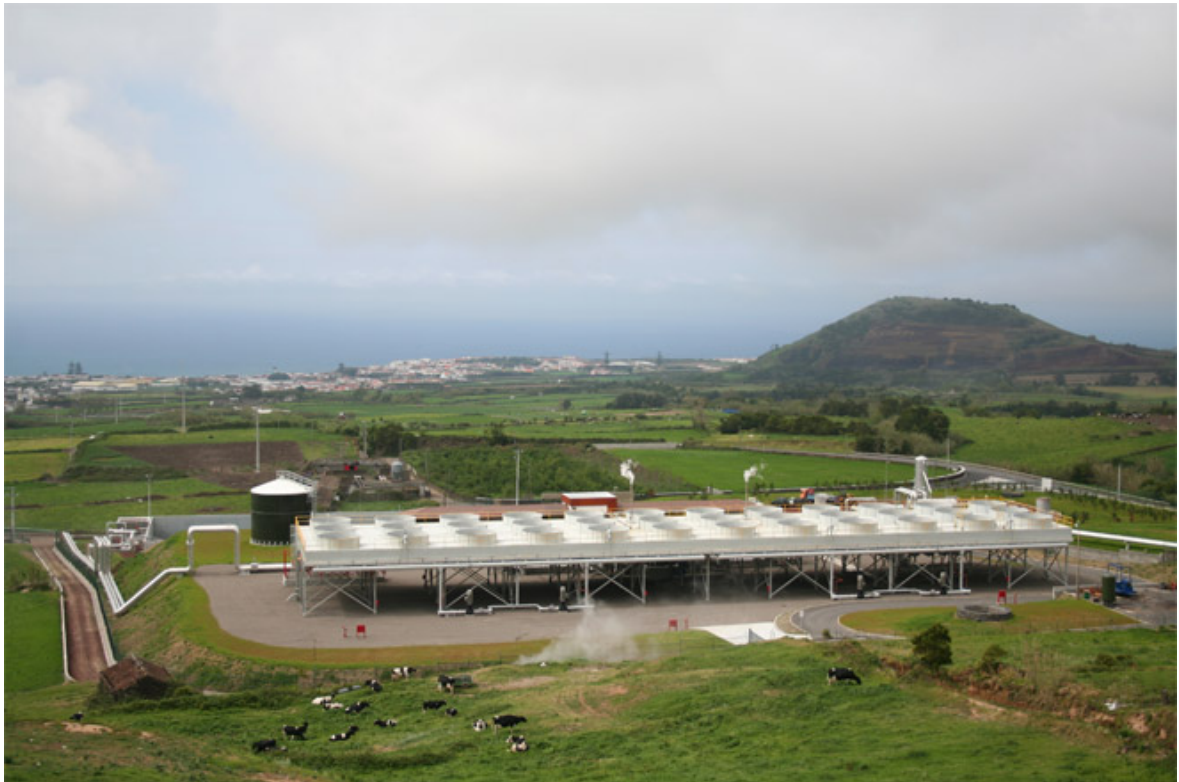
Figura 17. Central Geotérmica Piloto de Pico Vermelho (Fonte - http://siaram.azores.gov.pt/energia-recursos-hidricos/geotermia/_texto.html )
