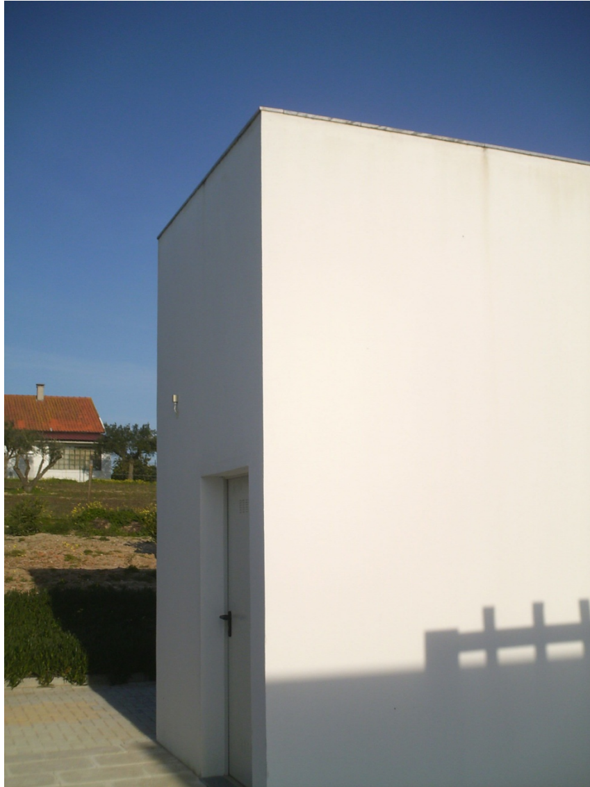
Figura 37. Casa das máquinas
