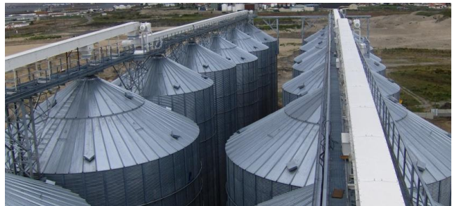
Ilustração 16 - Silos metálicos e sistemas de transporte dos cereais automatizados [18]
