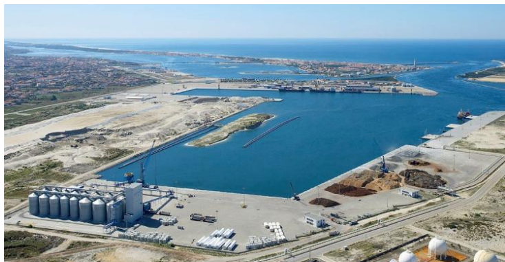
Ilustração 15 - Vista geral das instalações da empresa Sograin e o respectivo cais de acostagem [18]
