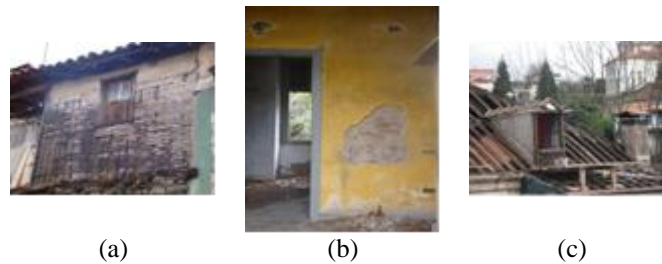
Figura 1 : Elementos construtivos de tabique; (a) parede exterior, Macedo de Cavaleiros; (b) parede divisória, Mirandela; (c) chaminé, Amarante
