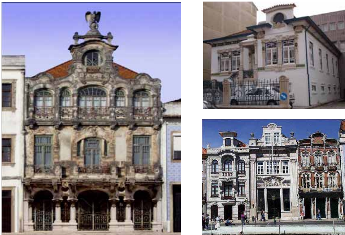
Figura 2 – Exemplos de edifícios em Art Nouveaux com paredes resistentes em adobe e elementos decorativos em pedra nas fachadas.
