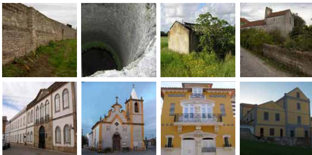
Figura 1 - Construções em adobe no distrito de Aveiro.
