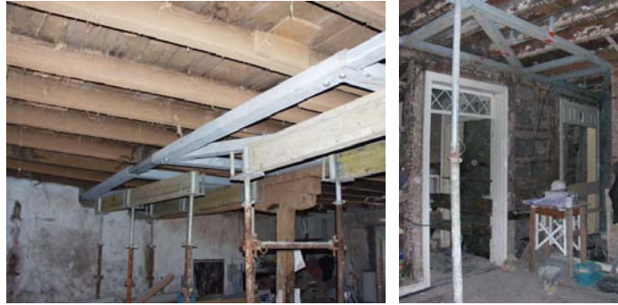
Figura 2: Treliça metálica colocada em posição central em relação às paredes laterais do edifício [5]
