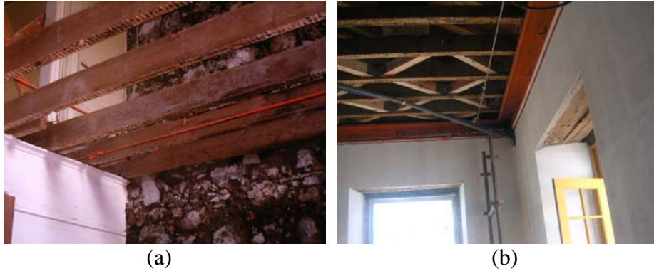
Figura 5: Tirantes: (a) Varões, (b) Cabos [5]
