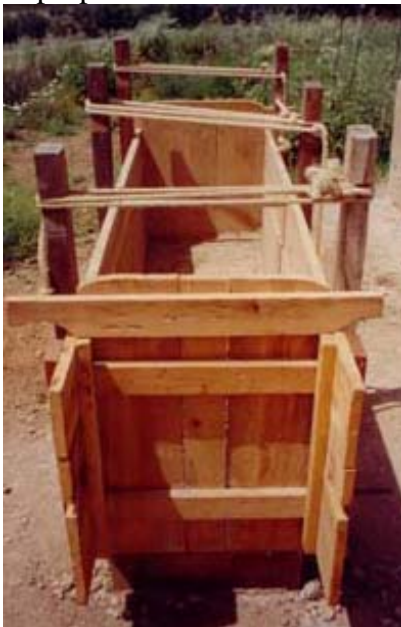
Figura 6-a: Cofragem de madeira para a construção de uma parede em Taipa (Fonte: [11])
