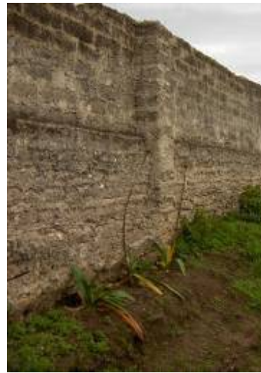
Figura 7-b: Parede em Adobe (Fonte: [14])
