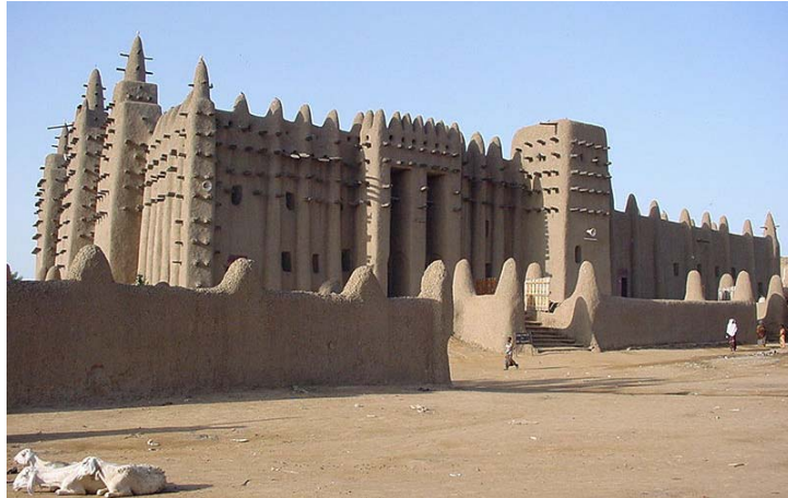
Figura 3: Cidade de Djénné, Mali. (Fonte: [5])
