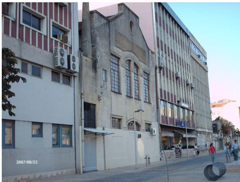
Figura 11 – Edifício de alvenaria entre dois de betão armado
