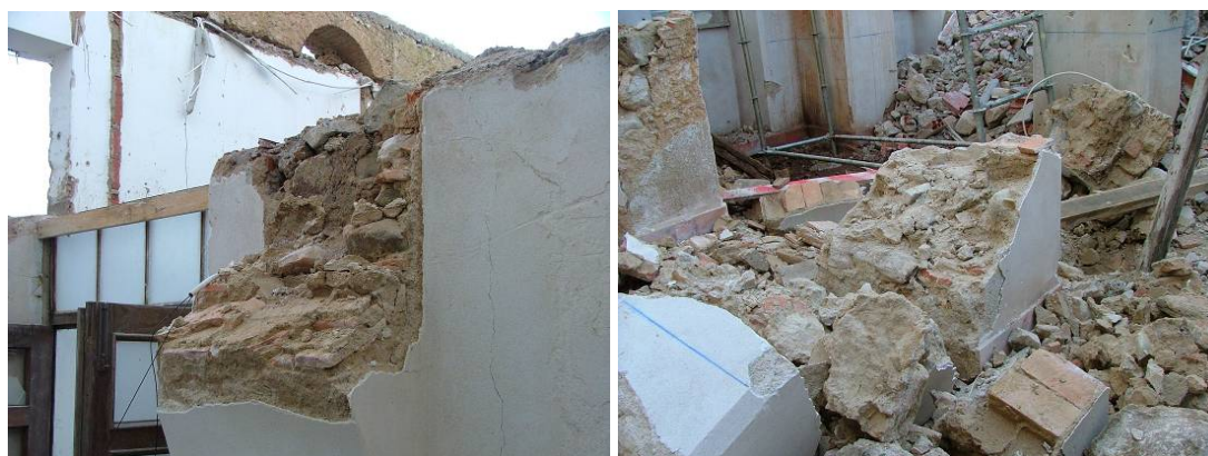
Figura 2: Constituição dos pilares e dos arcos do Museu de Aveiro
