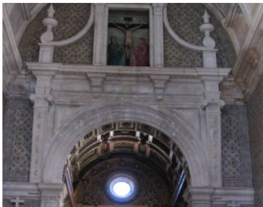
Figura 10: Aspecto final do Arco-Cruzeiro após instalação do sistema de monitorização
