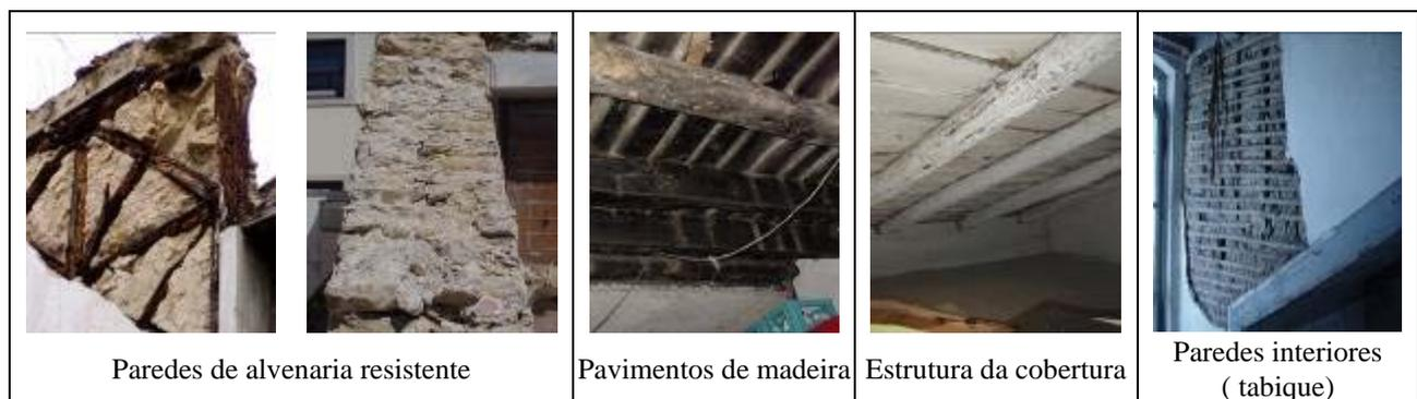
Figura 3: Detalhes construtivos dos edifícios antigos
