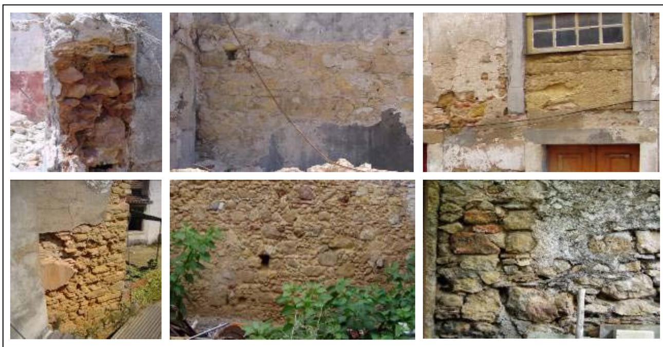
Figura 1: Alvenarias irregulares de pedra calcária na Baixa de Coimbra
