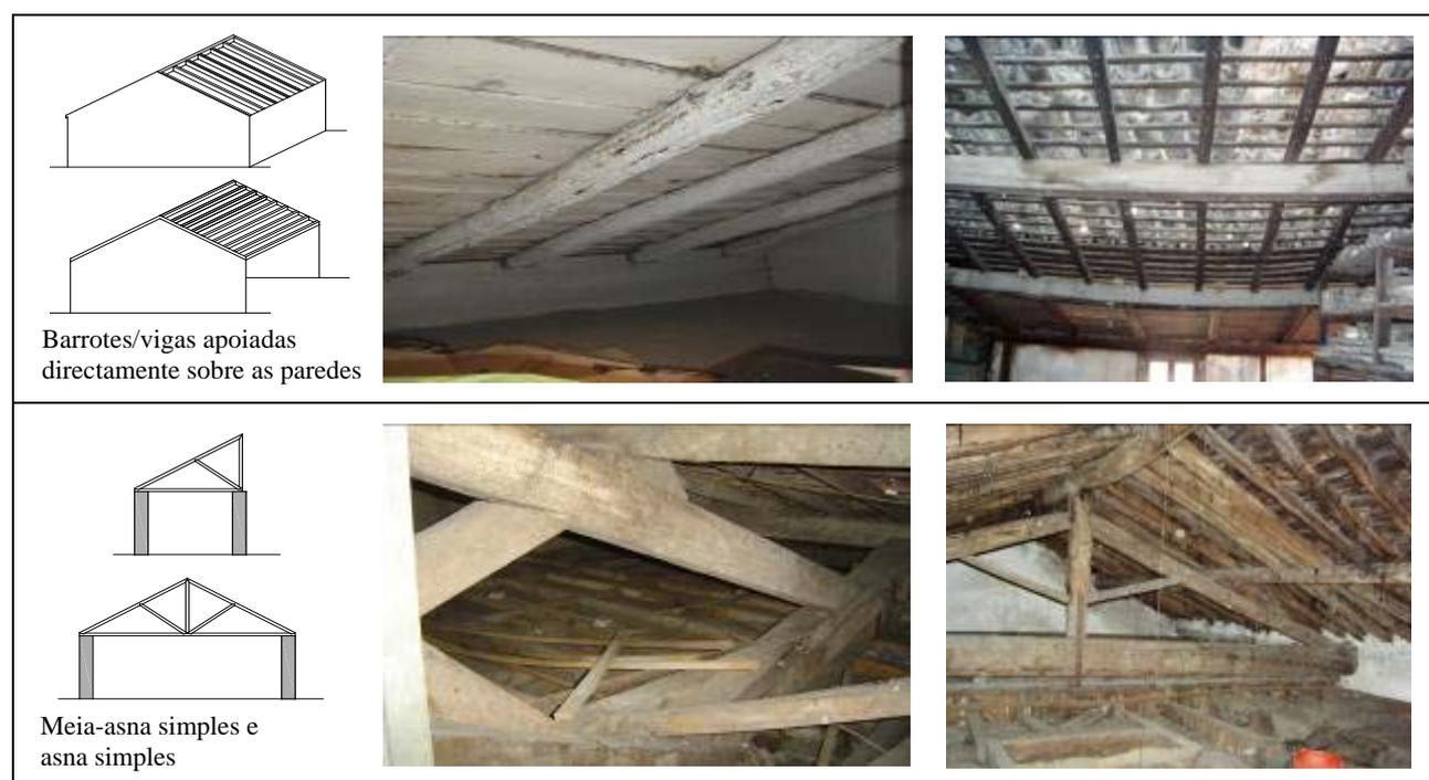
Figura 14: Geometria e constituição da estrutura de suporte das coberturas da Baixa de Coimbra
