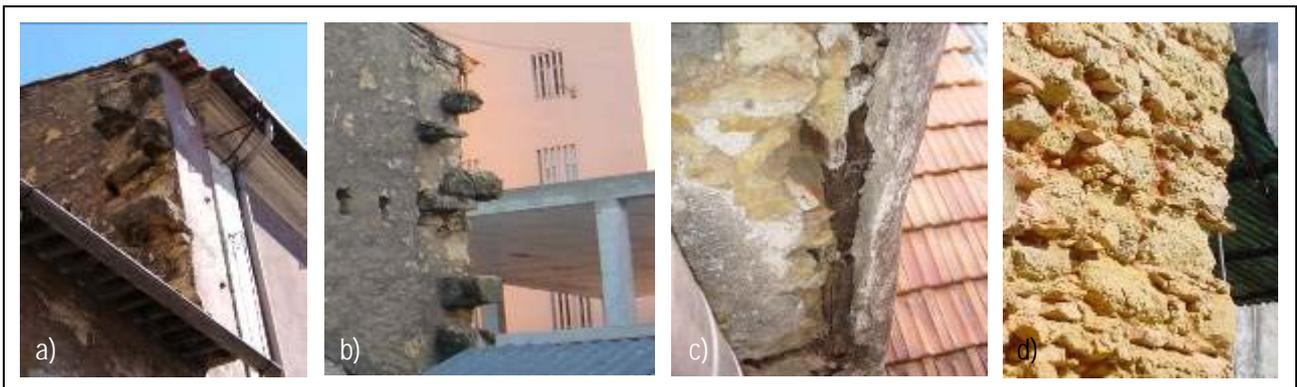
Figura 7: Cunhais e ligação entre paredes ortogonais
