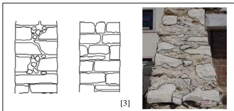
Figura 3: Secção transversal das paredes de pedra
