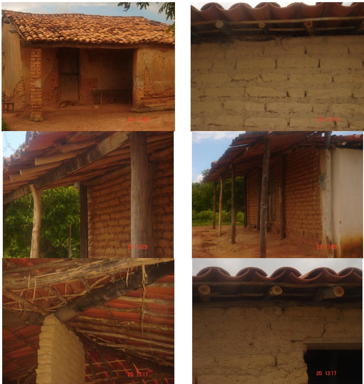
Figura 04 – Detalhes construtivos das construções em adobe.
