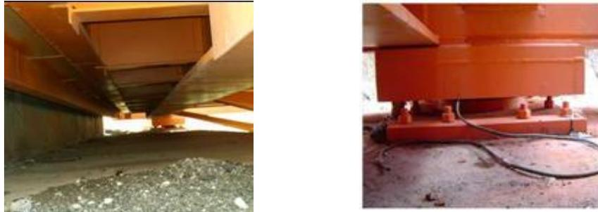
**Figura 3 Sistema de aislamiento multirrotacional del Puente Infiernillo II**
