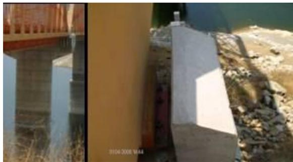
**Figura 2 Topes sísmicos del Puente Infiernillo II**
