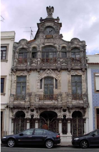
Fig. 16 – Casa Major Pessoa antes da intervenção [Varum, H. et al; 2008]
