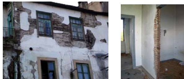
a) Exterior wall
