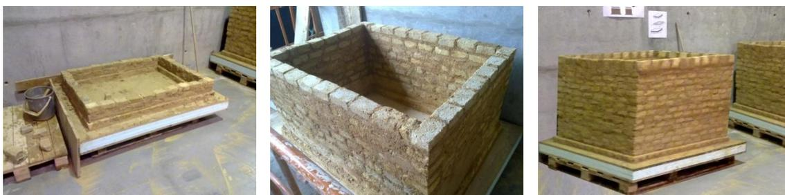
Fig. 5.- Diferentes fases da construção da célula de teste número 2.
