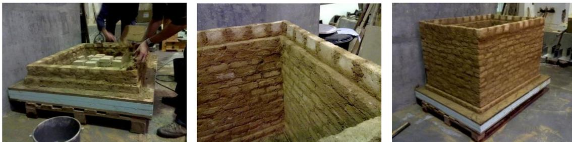
Fig. 3: Construção da célula de teste número 1.
