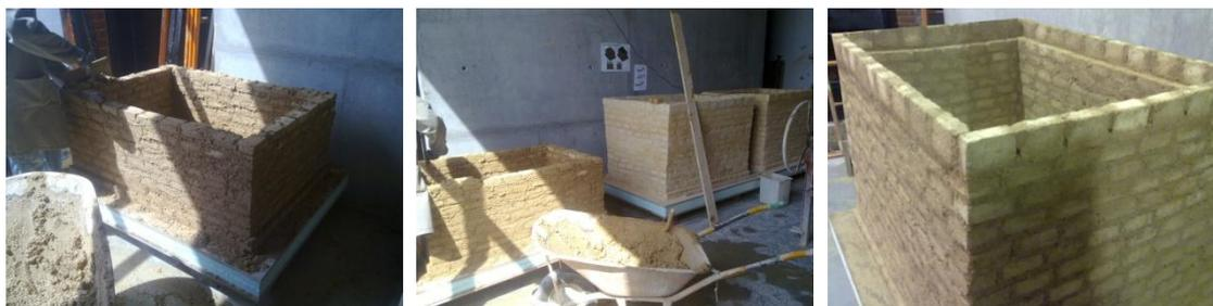
Fig. 8.- Diferentes fases da construção da célula de teste número 3.
