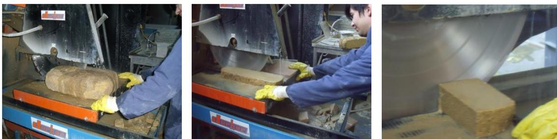
Fig. 4.- Processo de corte dos adobes existentes para a construção da segunda célula de teste
