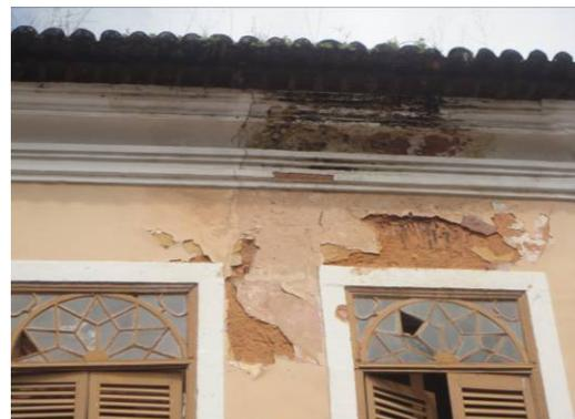
Figura 11. a) Vegetação rasteira que se prolifera nos telhados vizinhos; b) Verga reta em tijoleira, com reboco desagregado, ocasionado por infiltração na cobertura e cimalha. Fotos: a) Daniel Lopes; b) IPHAN 3ª SR.
