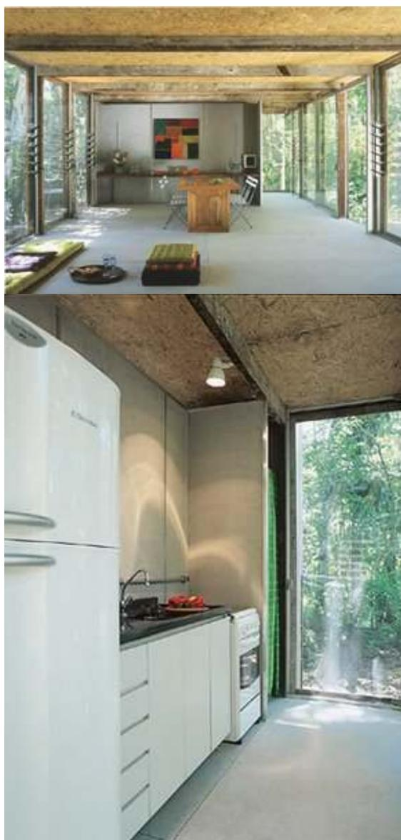
Figura 1 - Casa ecológica com forro de chapas de OSB (aglomerado de sobras de madeira prensada).
