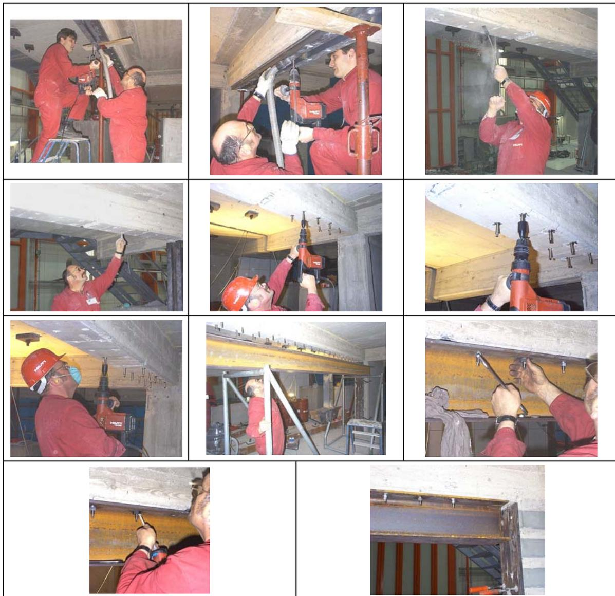
Fig. 14 - Ancoragem das vigas metálicas ao pórtico envolvente de B.A.
