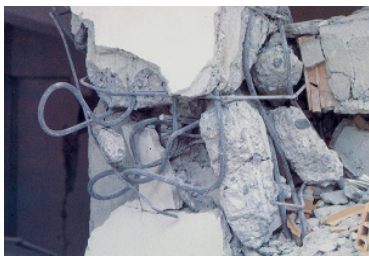
Figura 2: Pilares de betão armado com inadequada armadura de esforço transverso [19]
