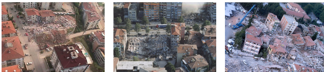
Figura 1: Danos provocados pelo sismo de Izmit, Kocaeli, Turquia, a 17 de Agosto de 1999
