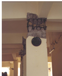
Figura 2: Pilares de betão armado com inadequada armadura de esforço transverso [19]
