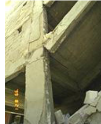
Figura 3: Vigas com comportamento não dúctil
