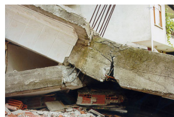
Figura 10: Mecanismo viga forte-pilar fraco
