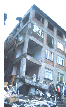
Figura 6: Resistência inadequada dos nós vigapilar [22]
