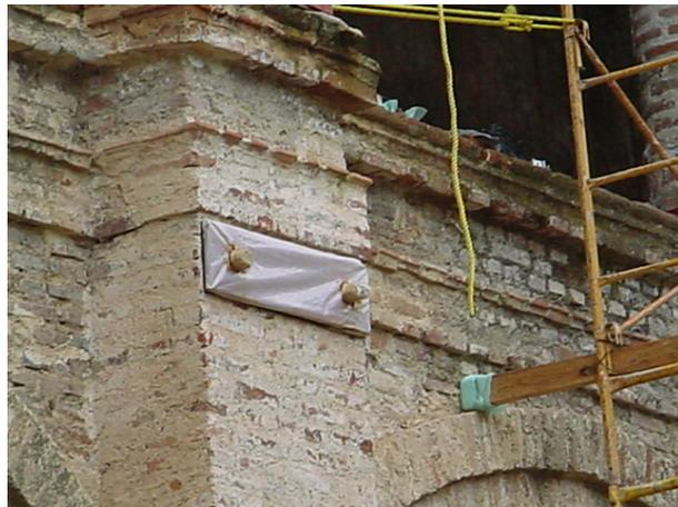
Figura 2 – Tensores con camisa de acero y placa de conexión
